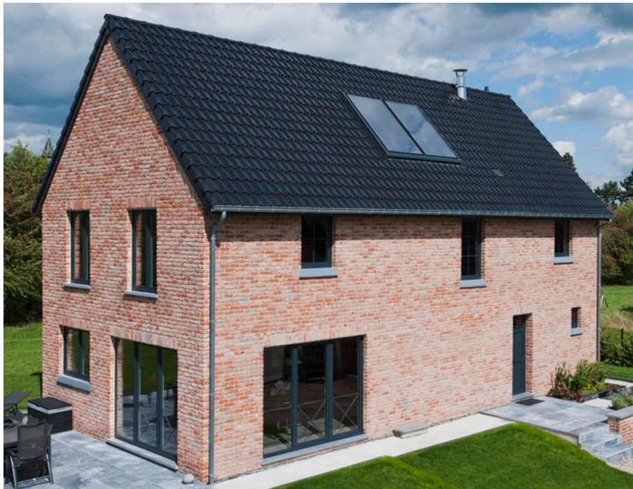
Gevel: Belle Epoque de Mons / Dak: Koramic Panne Antraciet mat
