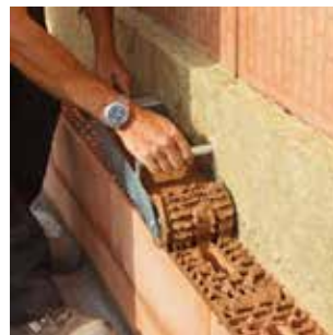
De scheidingsmuren tussen de zeven woningen zijn compleet ont dubbeld.
