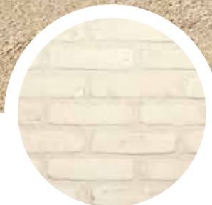
>Gevel Terca Domus Duifwit Architect Dedalus bvba, Eeklo
