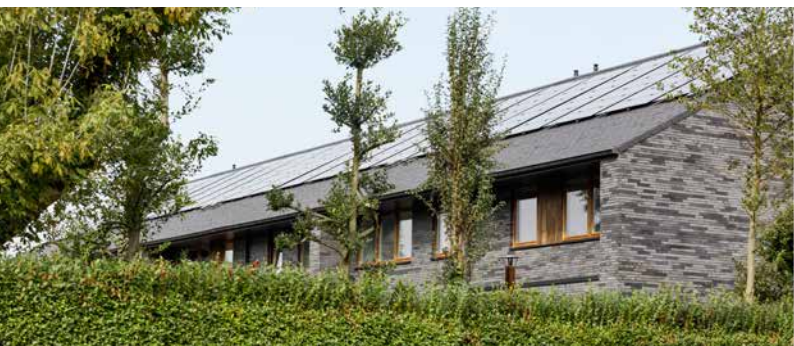
Door de gevelsteen te verlijmen, komen de rijke schakeringen nog sterker uit de verf.
