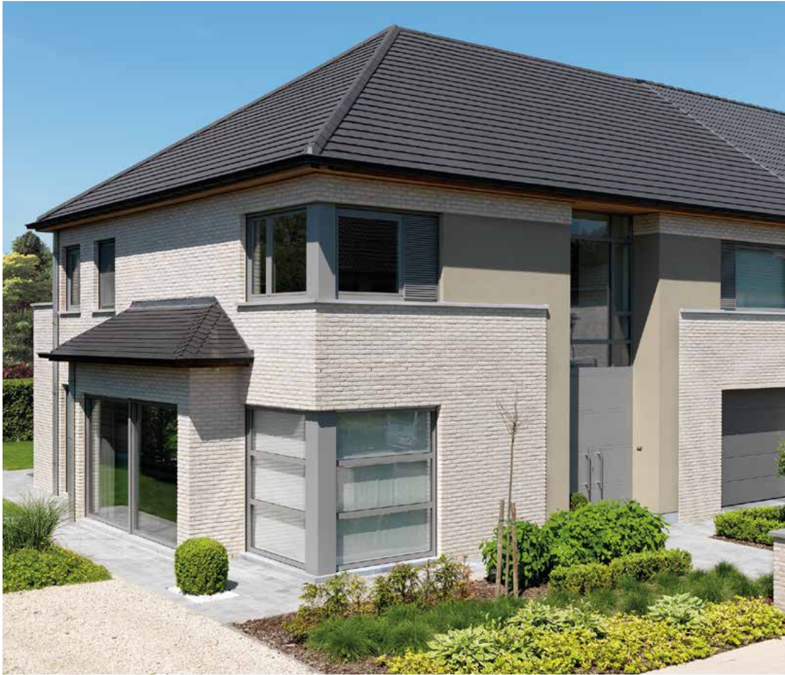
Gevel: Domus Casa Lena Dak: Koramic Vauban Antraciet mat en Tegelpan 301 Antraciet
