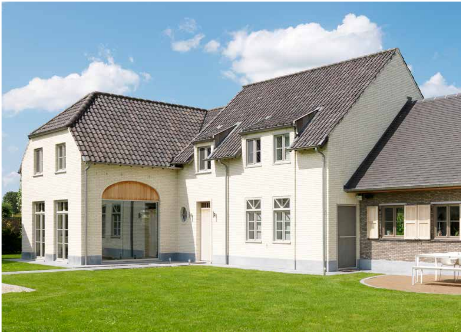
Gevel: Domus Duifwit / Dak: Koramic Oude Pottelbergse Pan 451 Vieilli blauw gesmoord en Tegelpan 301 Blauw gesmoord
