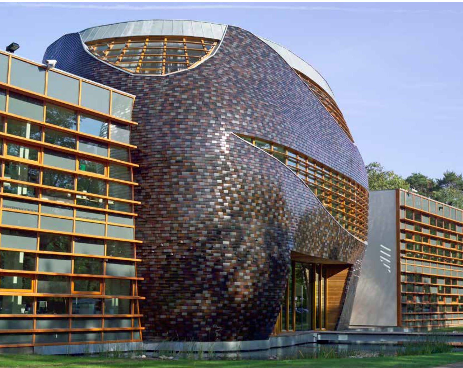
Tegelpan 301 - Mix van 25% Leikleur mat geglazuurd, 20% Antraciet, 25% Bruin geglazuurd, 15% Wijnrood geglazuurd en 15% Zwart geglazuurd Architect RAU, Thomas Rau, NDL, Amsterdam
