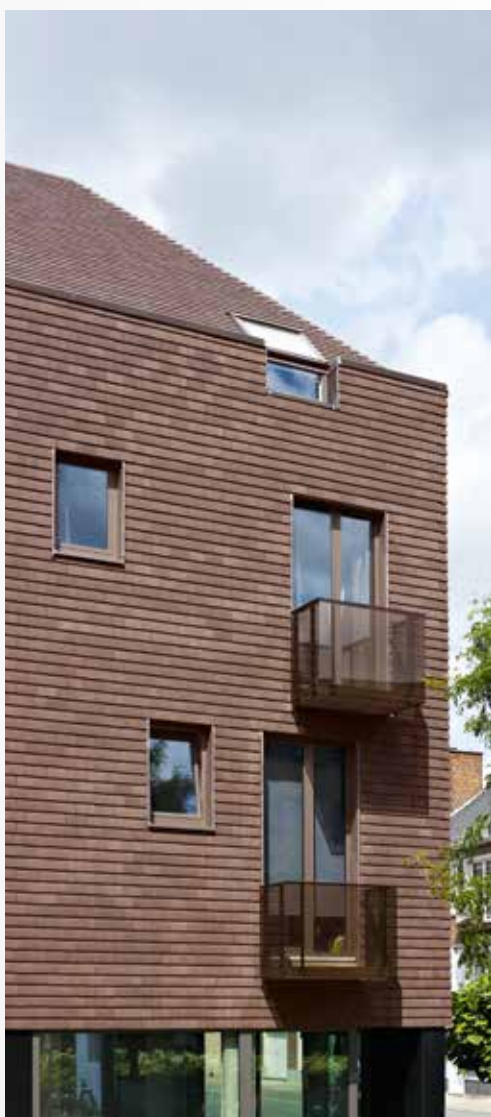
Tegelpan Plato - Oud koper bezand Architectenbureau Ensemble, Kortrijk
