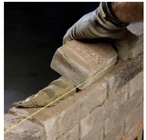
Grâce à l'évacuation aisée du mortier excédentaire, les briques peuvent être posées de manière extrêmement précise avec peu de corrections.
