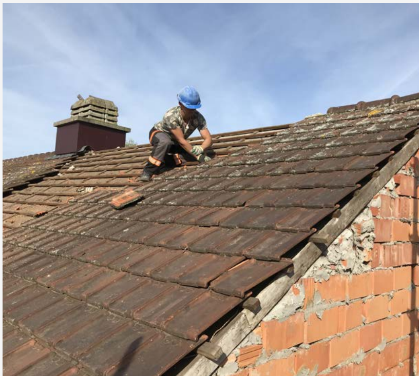
Keramische dakpannen worden van het dak gehaald.
