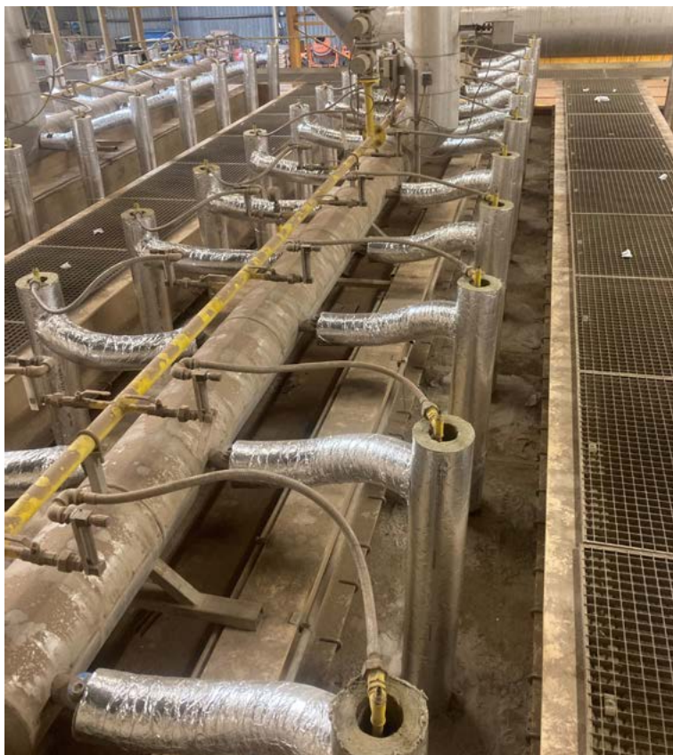
De branders van de ovens werden geïsoleerd.
