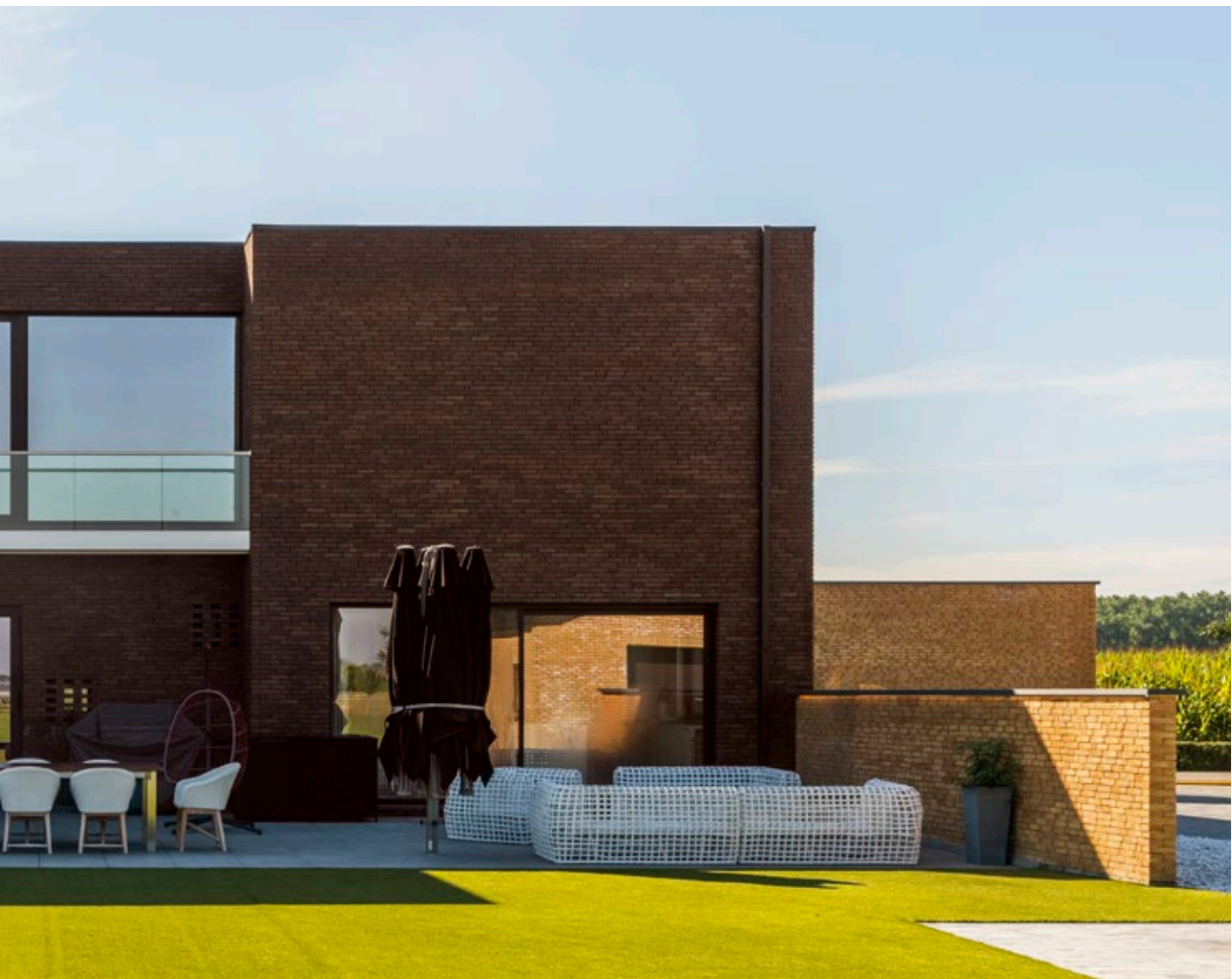
Architectenbureau Tyberghien & Partners, Gent
