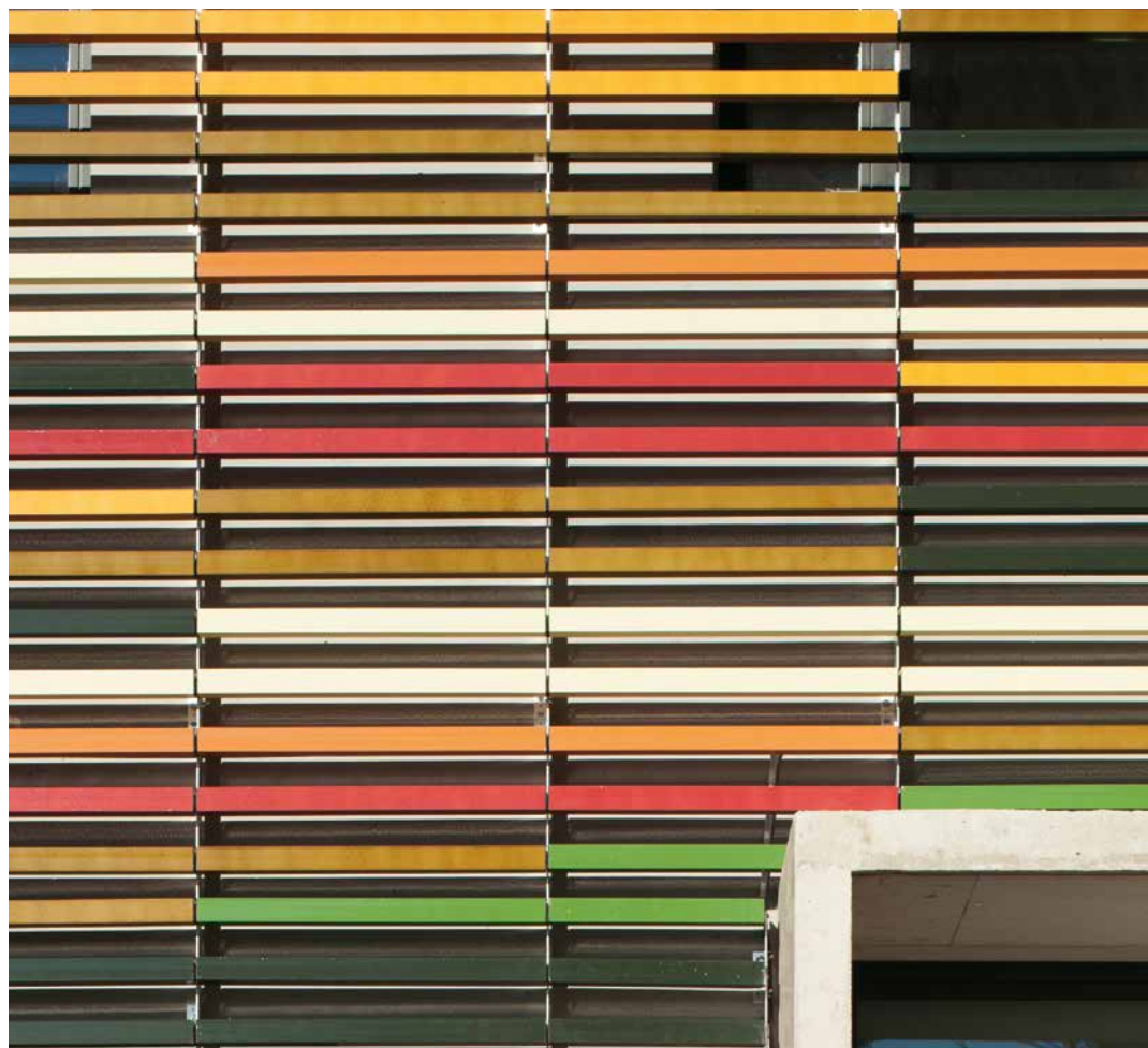
Collège Frédéric-Joliot-Curie, F-Aubagne (13) Architecte Architectes Cactus - Frédéric Seltzer et Antoine Beau - F-Marseille (13) Atelier d'architecture Rey Lucquet - F-Strasbourg (67) Maîtrise d'ouvrage Conseil Général des Bouches-du-Rhône Entreprise Dumez Méditerranée service Façade - F-Marseille (13) Photographe Philippe Biron
