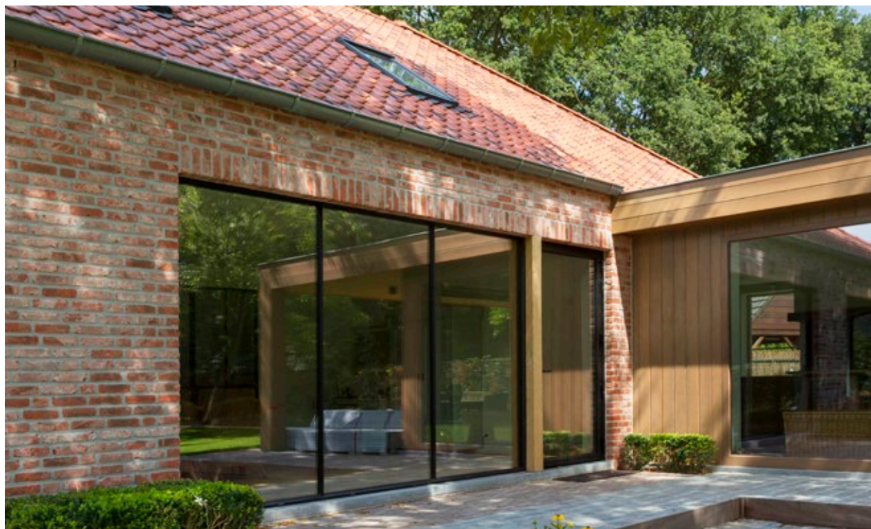
Façade : Belle Epoque de Liège / Toit : Koramic Tuile Tempête 44 Vieux Latem rouge et Vieux Latem bleu fumé
