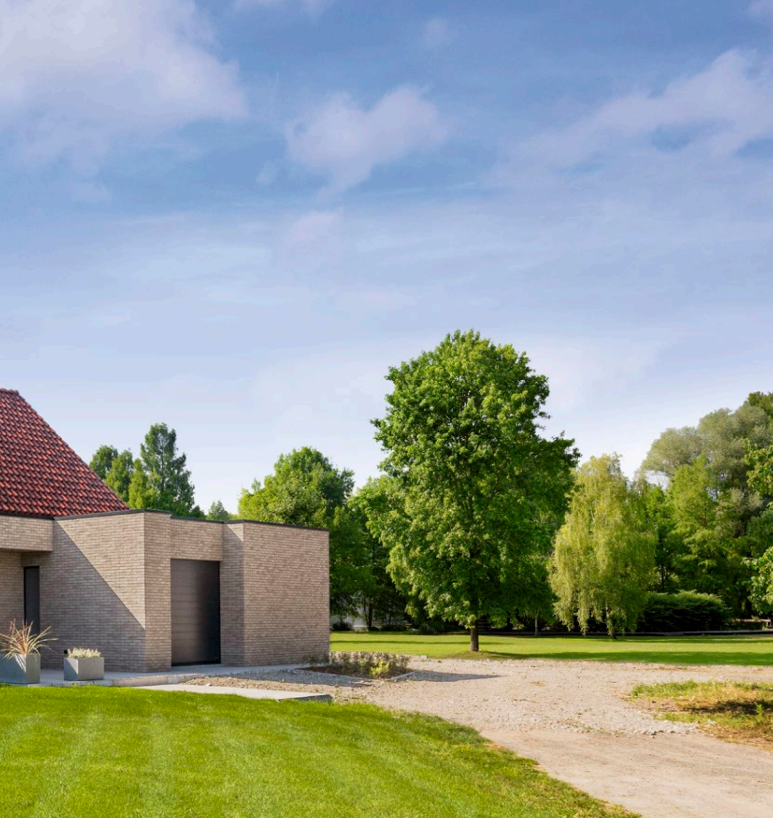
Architectenburo Acke - Van Wynsberghe, Assenede
