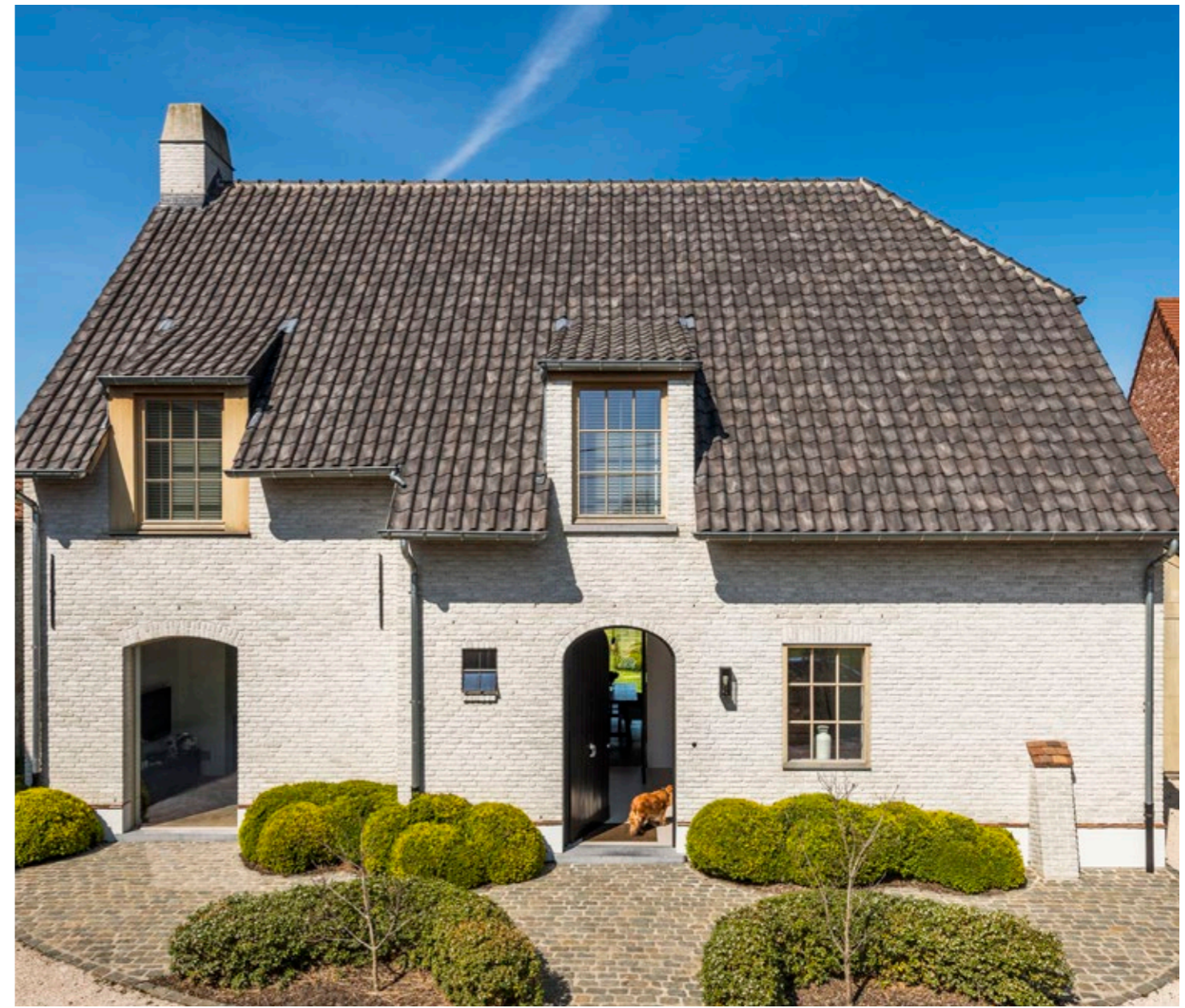
Façade : Terca Domus Casa Lena / Toit : Vieille tuile Pottelberg 451 Vieilli bleu fumé Architecte Miranda De Boeck, Lede
