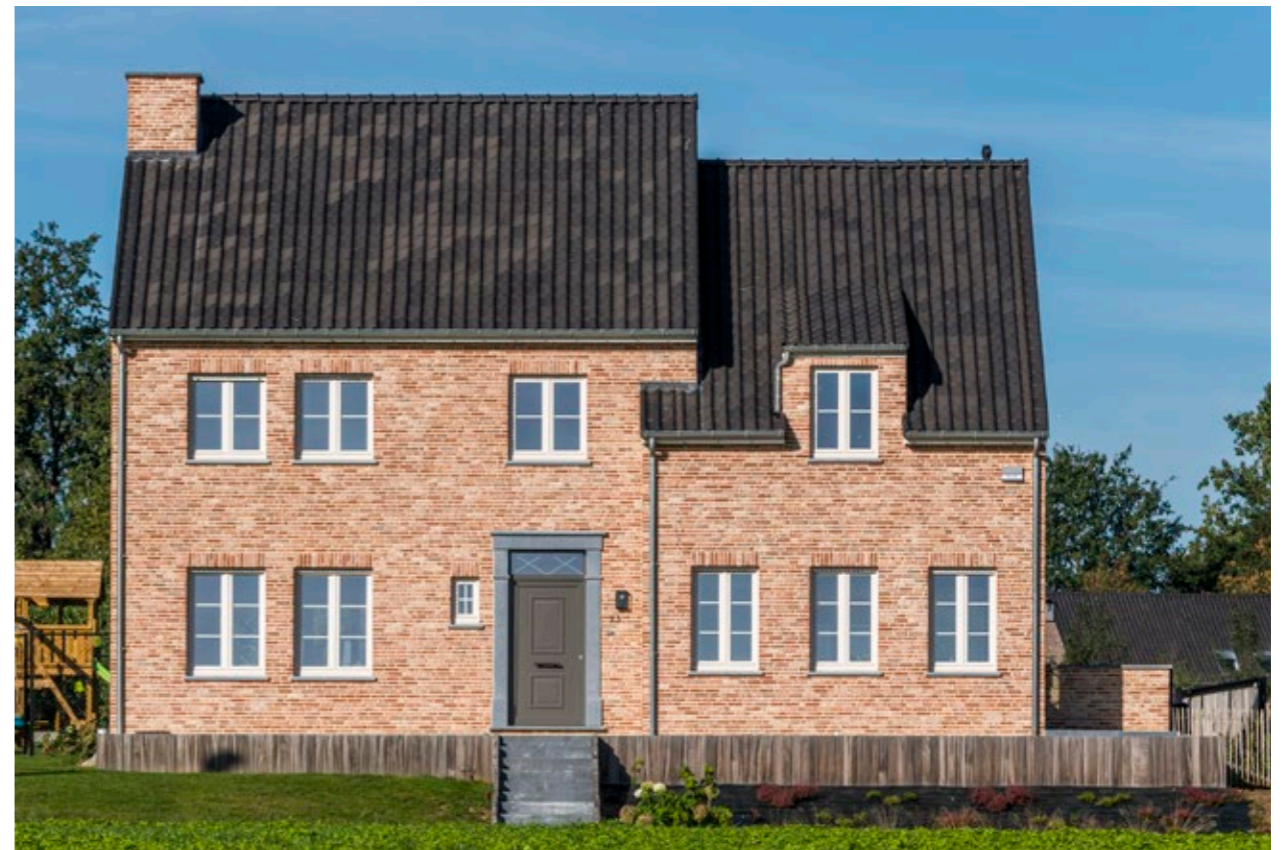
Façade : Terca Belle Epoque de Mons / Toit : Koramic OVH Klassiek Bleu fumé Architecte Herman De Becker, Glabbeek
