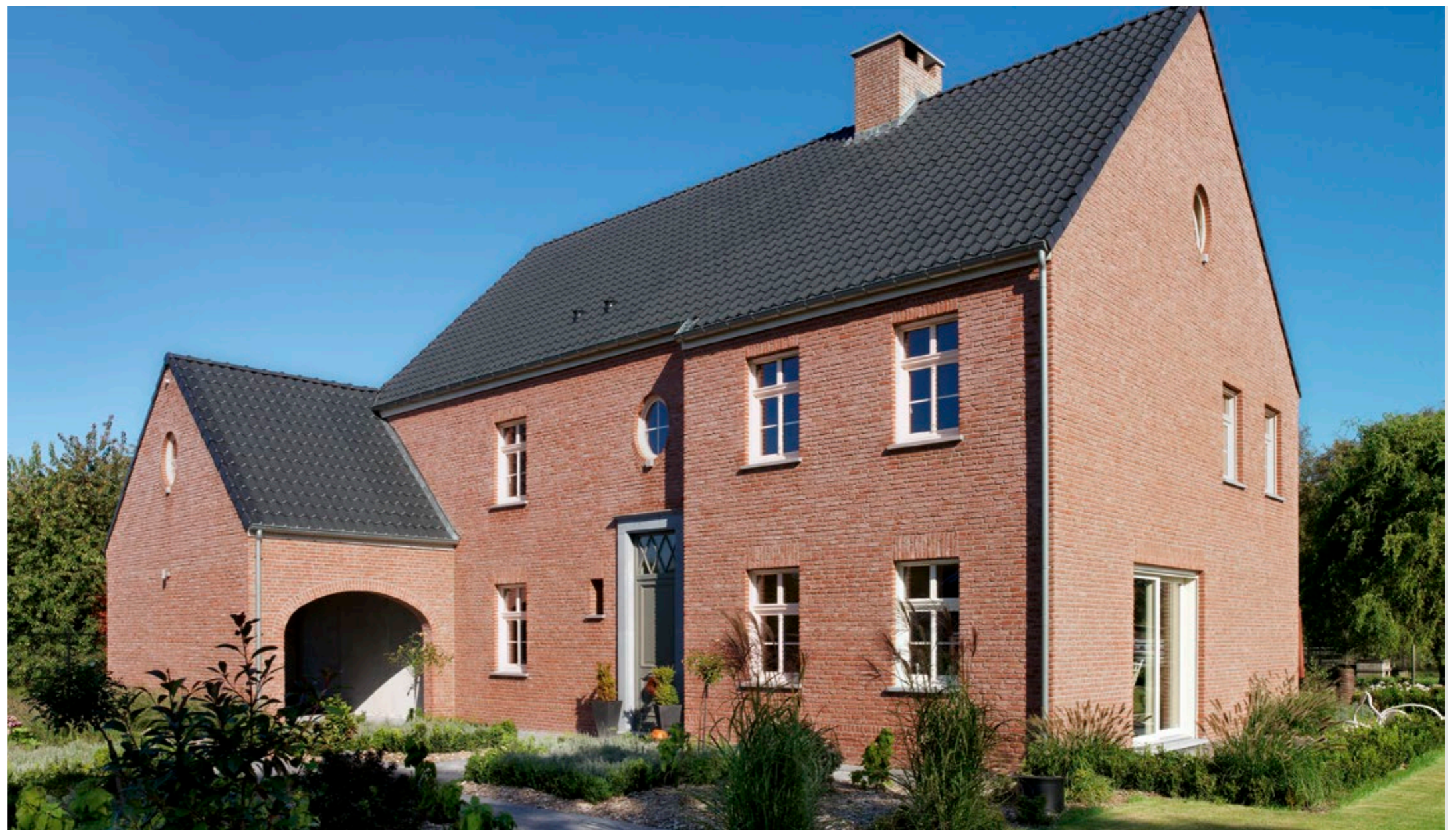
Terca Rustica Oud Malle Architectes Joris Cools et Daniëlle Matthyssen, Wuustwezel
