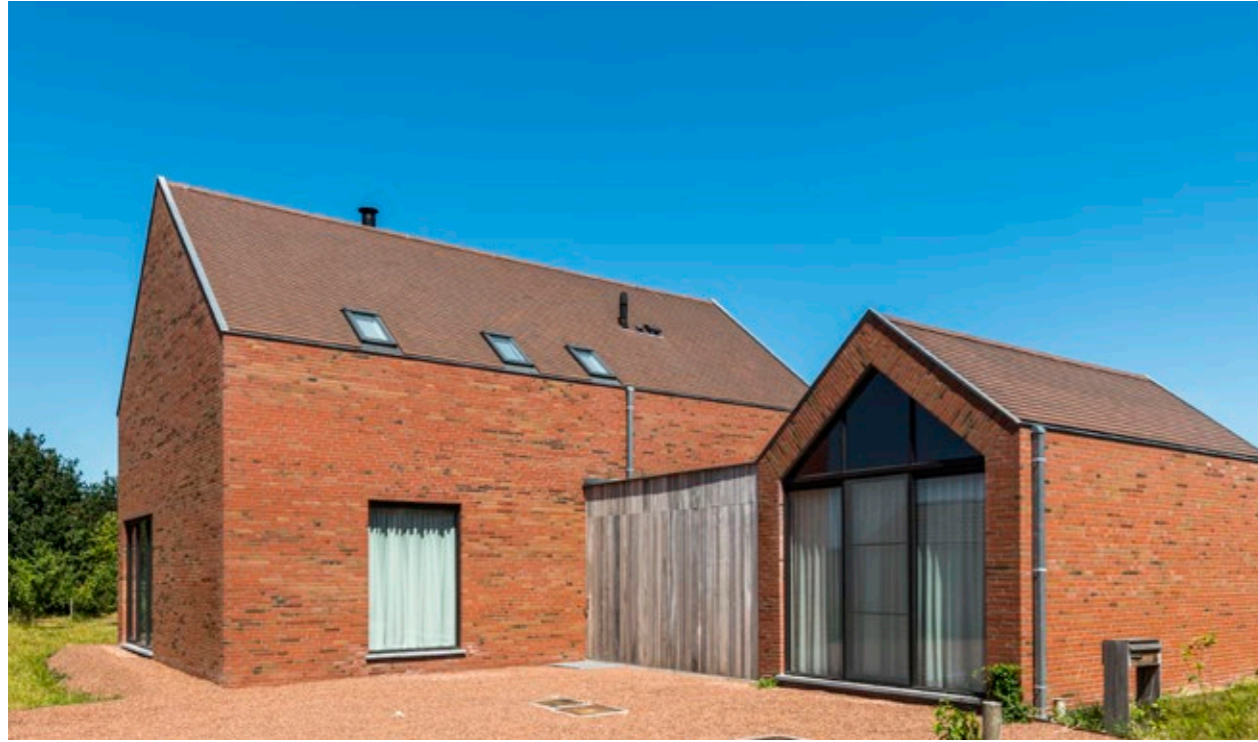
Façade : Terca Elignia Robinia / Toit : Koramic Tuile Plate 301 Rustique Architectenbureau Dirk Devenyns & Trui Vanden Berghe, Kluisbergen
