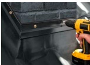
**Profil d'étanchéité en aluminium pour remplaçants du plomb**
