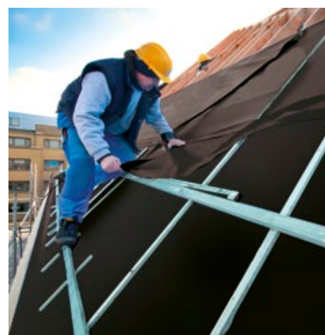
Recuperatiepannen laten ter hoogte van de overlapping meestal veel zonlicht door. Dankzij zijn hoge uv-stabiliteit is Fleece Maxi de ideale onderdakfolie om hier komaf mee te maken.
