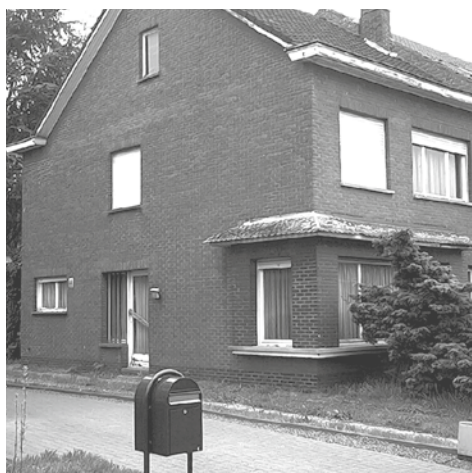
Voor de renovatie
