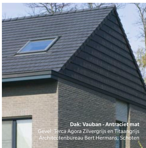
Na de renovatie
