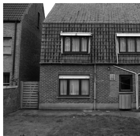
Voor de renovatie
