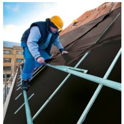
Recuperatiepannen laten ter hoogte van de overlapping meestal veel zonlicht door. Dankzij zijn hoge uv-stabiliteit is Fleece Maxi de ideale onderdakfolie om hier komaf mee te maken.
