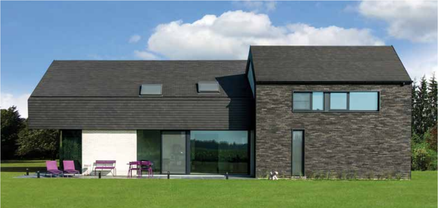
Façade : Marono Étouffé / Toiture : Koramic Tuile Plate Plato Bleu fumé
