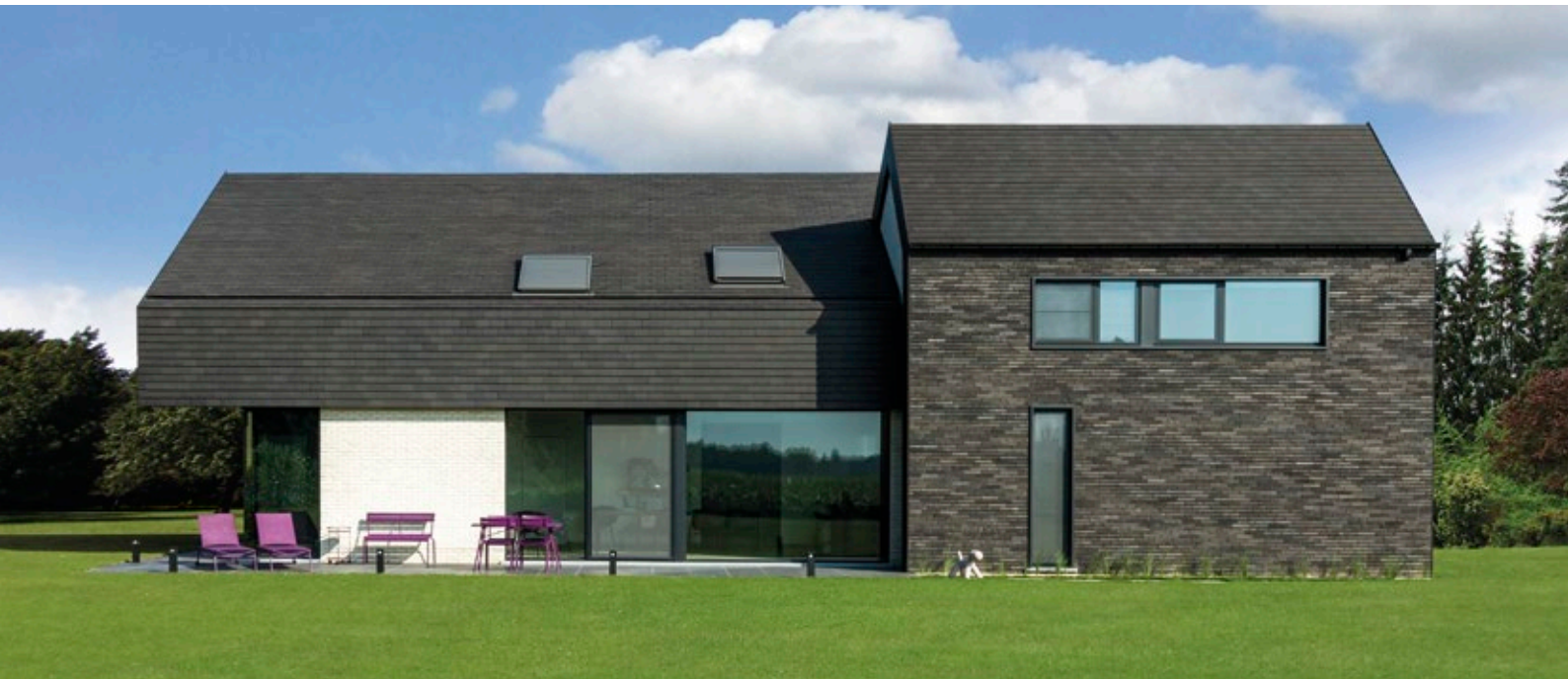
Gevel: Terca Marono Gesmoord / Dak: Koramic Tegelpan Plato Blauw gesmoord
