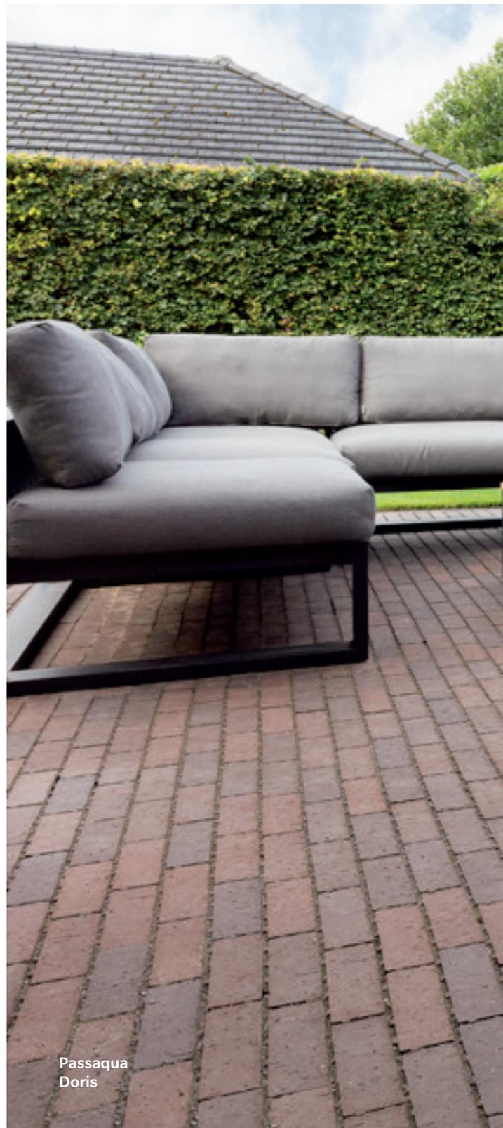
Mais d’autres aspects environnementaux importants ont également joué dans le choix des pavés Passaqua par les occupants. Malgré l’expansion de la surface pavée, l’eau peut ‘passer’ via les joints les plus larges, grâce aux écarteurs. Le maître d’ouvrage avait également prévu l’aménagement d’un bassin afin que l’eau collectée puisse continuer à s’infiltrer lentement dans le sol. **Un choix très écologique.**
