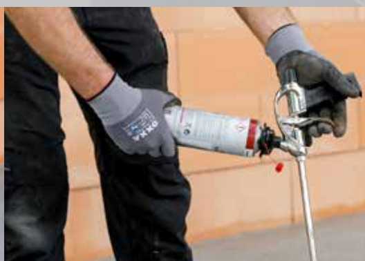
4. Het debiet regelen met de regelschroef
