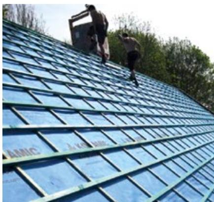
Grâce à son revêtement spécial, Fleece Plus résiste mieux aux fluctuations de température et aux rayons UV que les écrans de sous-toiture traditionnels. En outre, il s'agit d'un écran capillaire.
