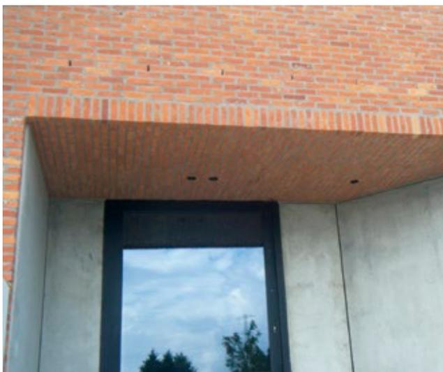
Les plaquettes vous permettent d'apporter une petite touche esthétique impossible à réaliser avec une 'grande' brique de parement traditionnelle.
