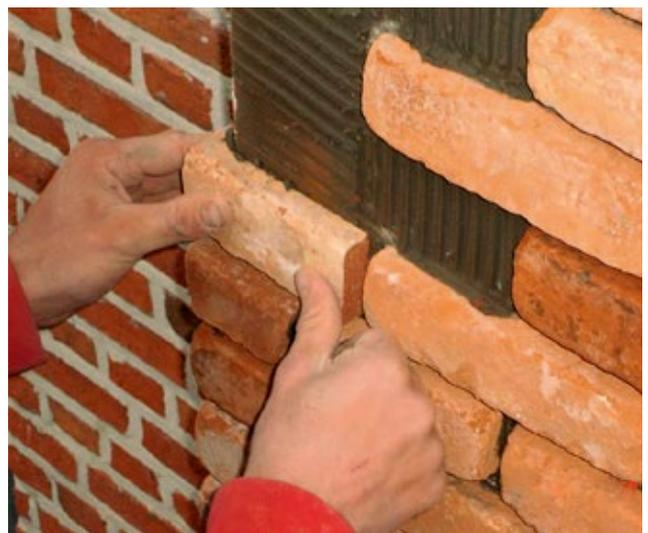
Les plaquettes forment la solution idéale pour les endroits où vous ne disposez pas de la largeur minimum de 9 cm.
