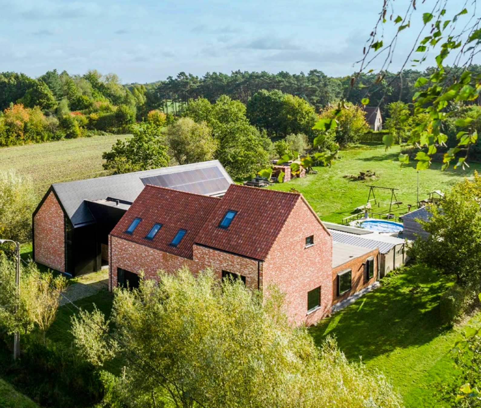
Na de renovatie
