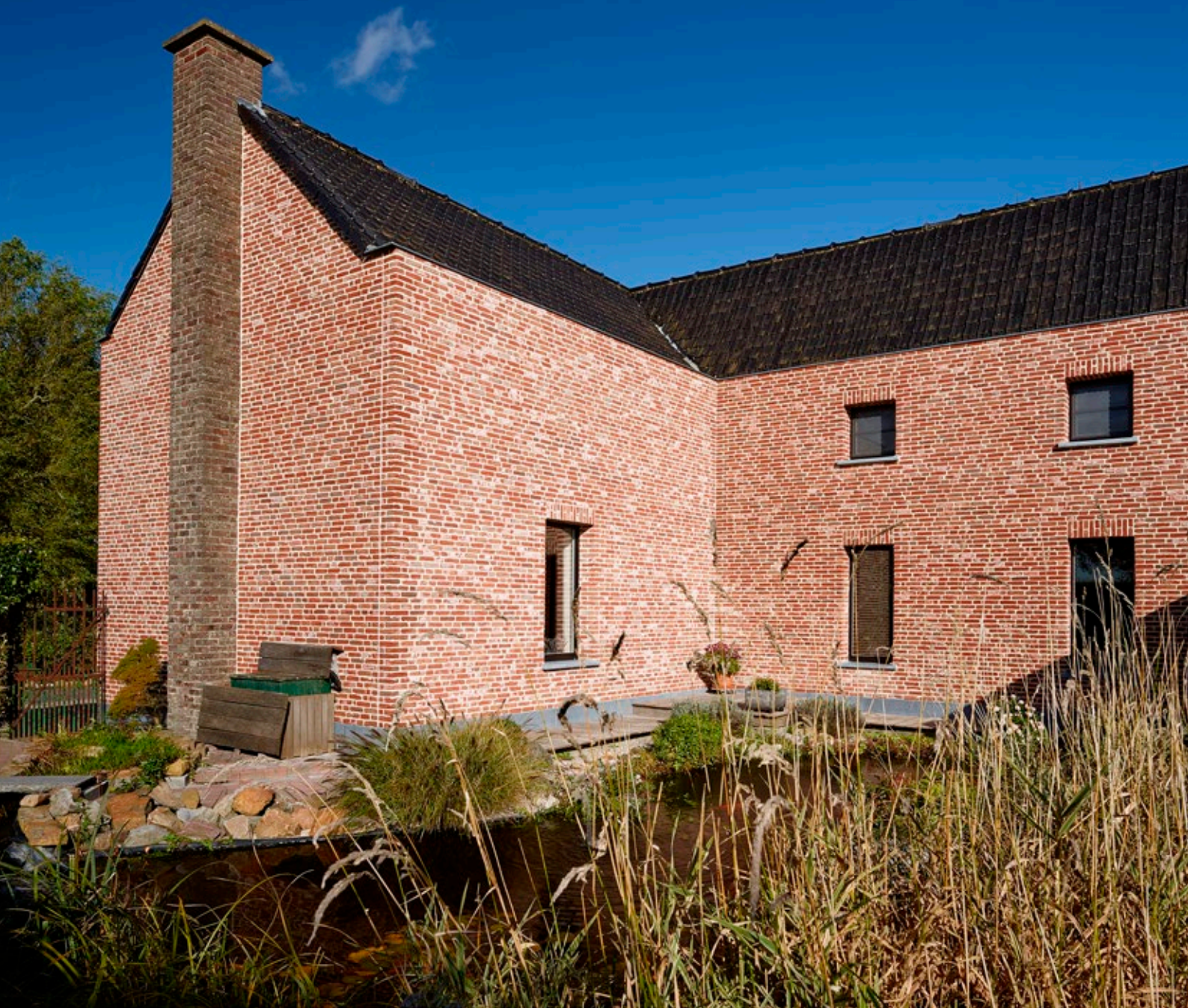
Na de renovatie
