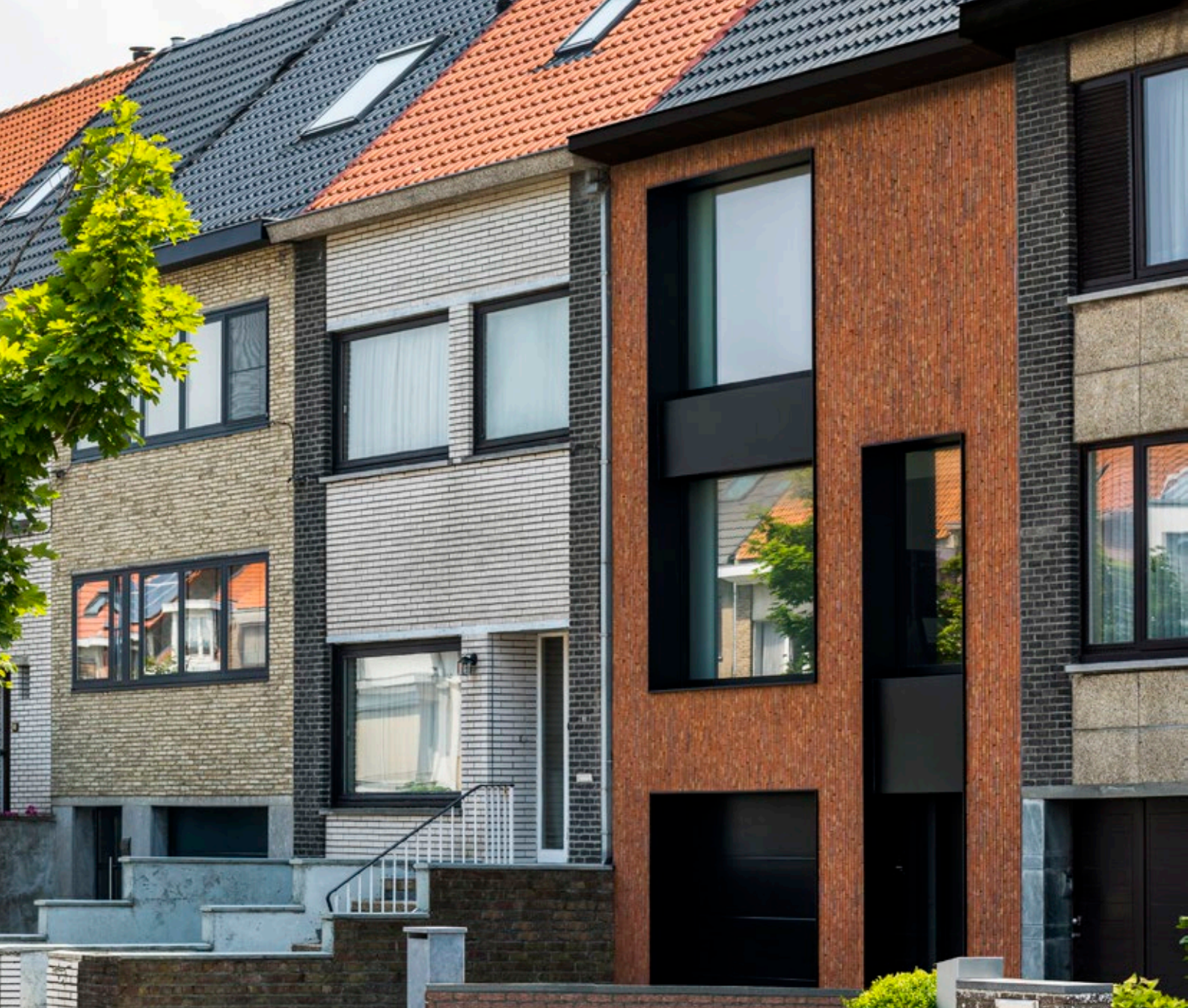
Na de renovatie
