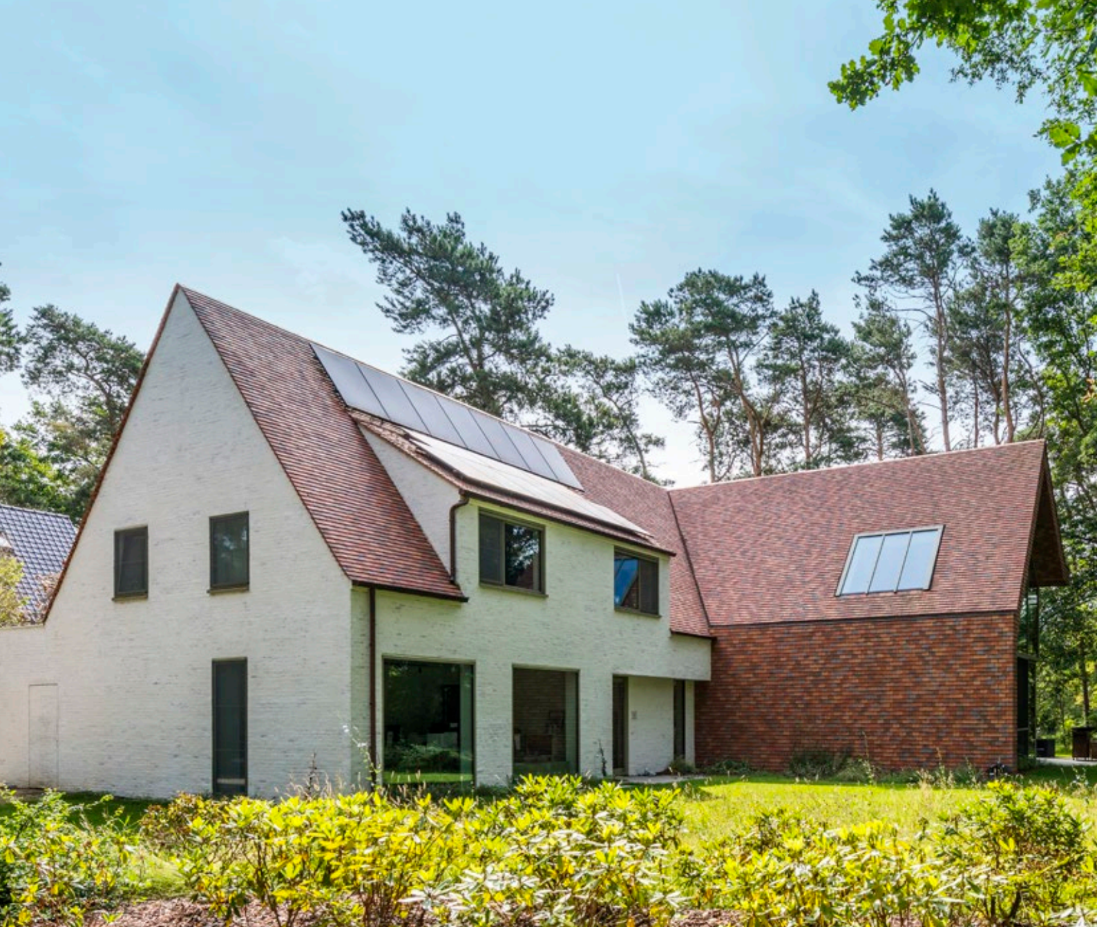
Na de renovatie
