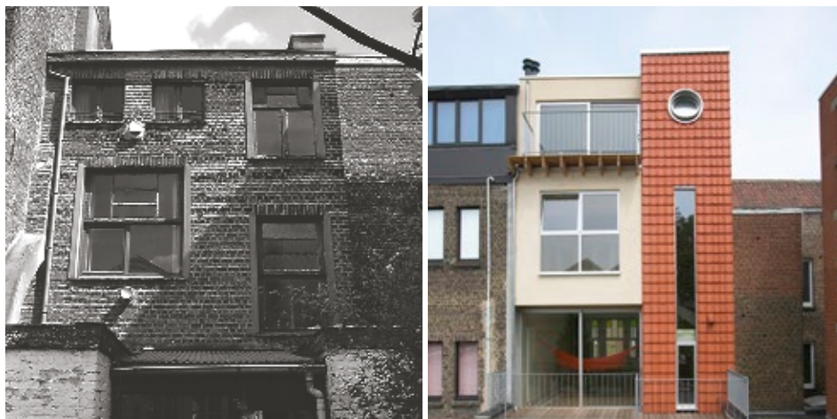
Voor de renovatie
