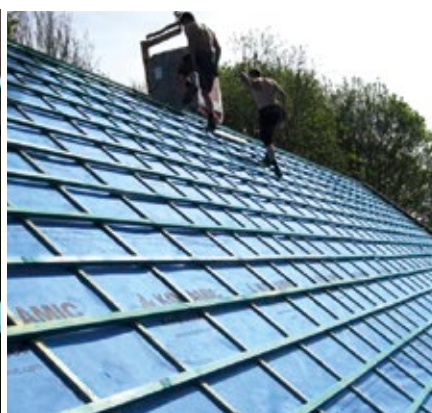
Door zijn speciale coating is Fleece Plus beter bestand tegen temperatuurschommelingen en UV-stralen dan traditionele onderdakfolies. Bovendien is de folie capillair.
