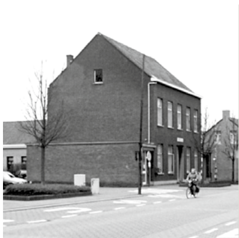
Voor de renovatie
