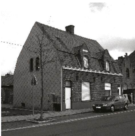
Voor de renovatie
