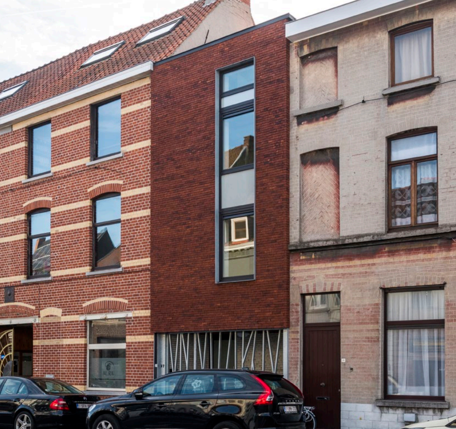
Na de renovatie
