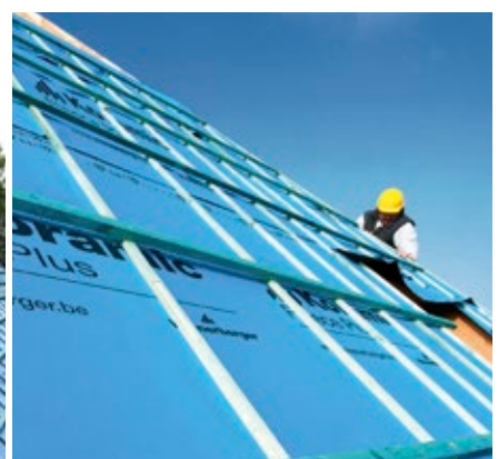
Omwille van zijn hoge UV-stabiliteit is Fleece Maxi uiterst geschikt als onderdakfolie bij recuperatiepannen. Die laten ter hoogte van de overlappingsen meestal veel zonlicht door.
