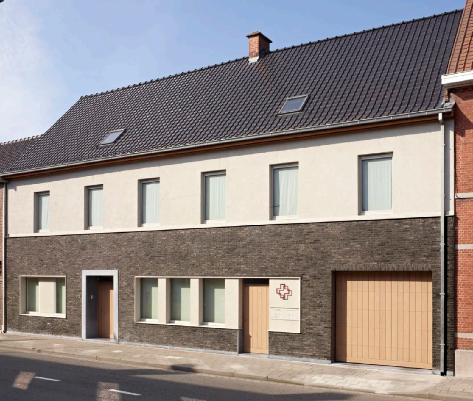
Na de renovatie
