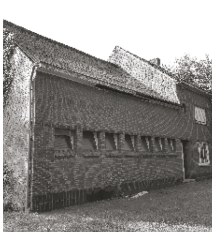
Voor de renovatie
