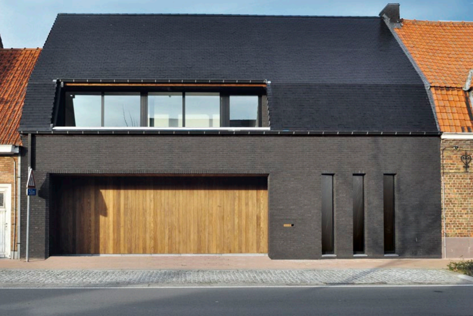
Na de renovatie
