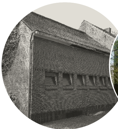
Voor de renovatie
