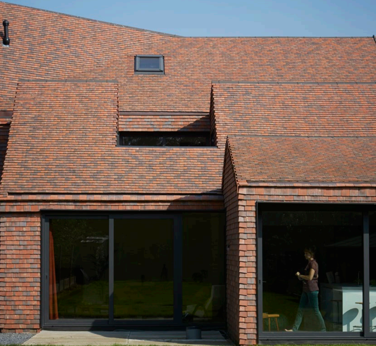
Na de renovatie
