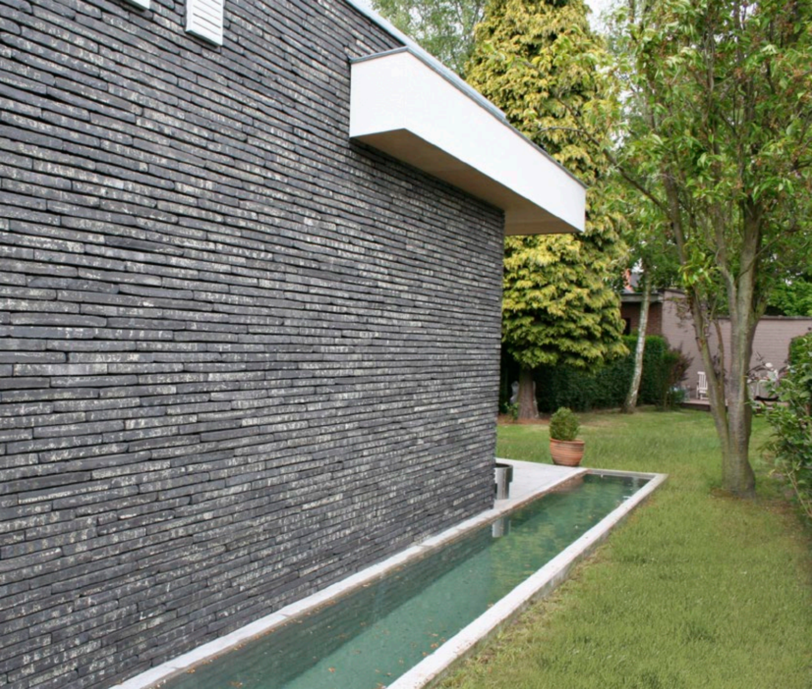
Na de renovatie
