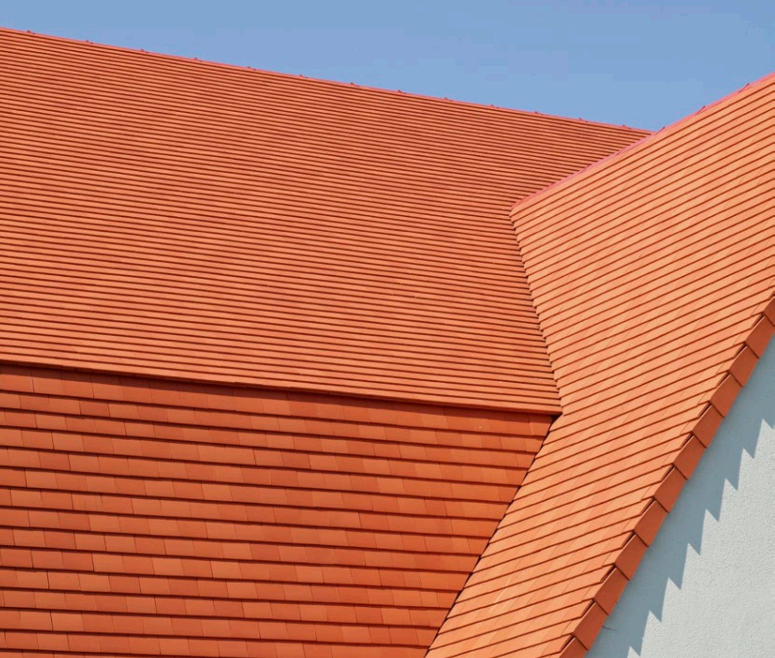
Na de renovatie
