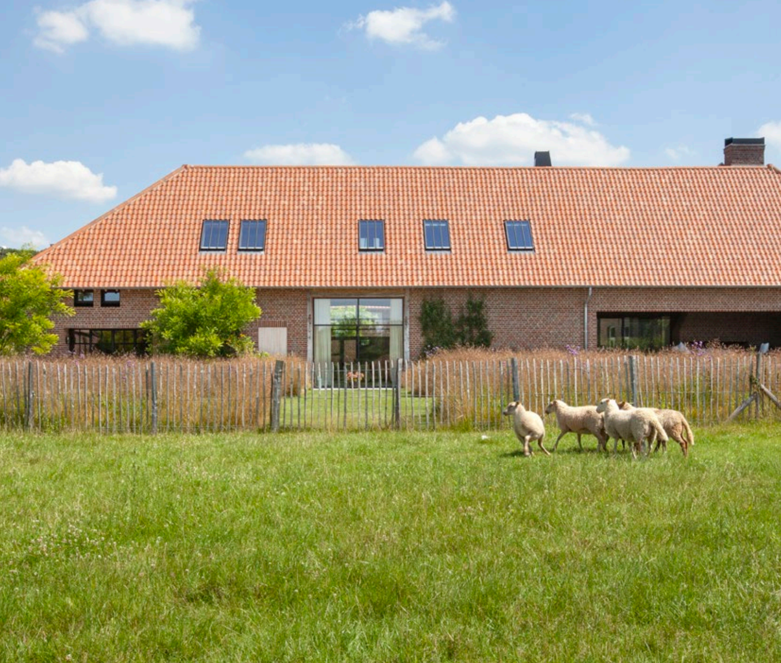
Na de renovatie
