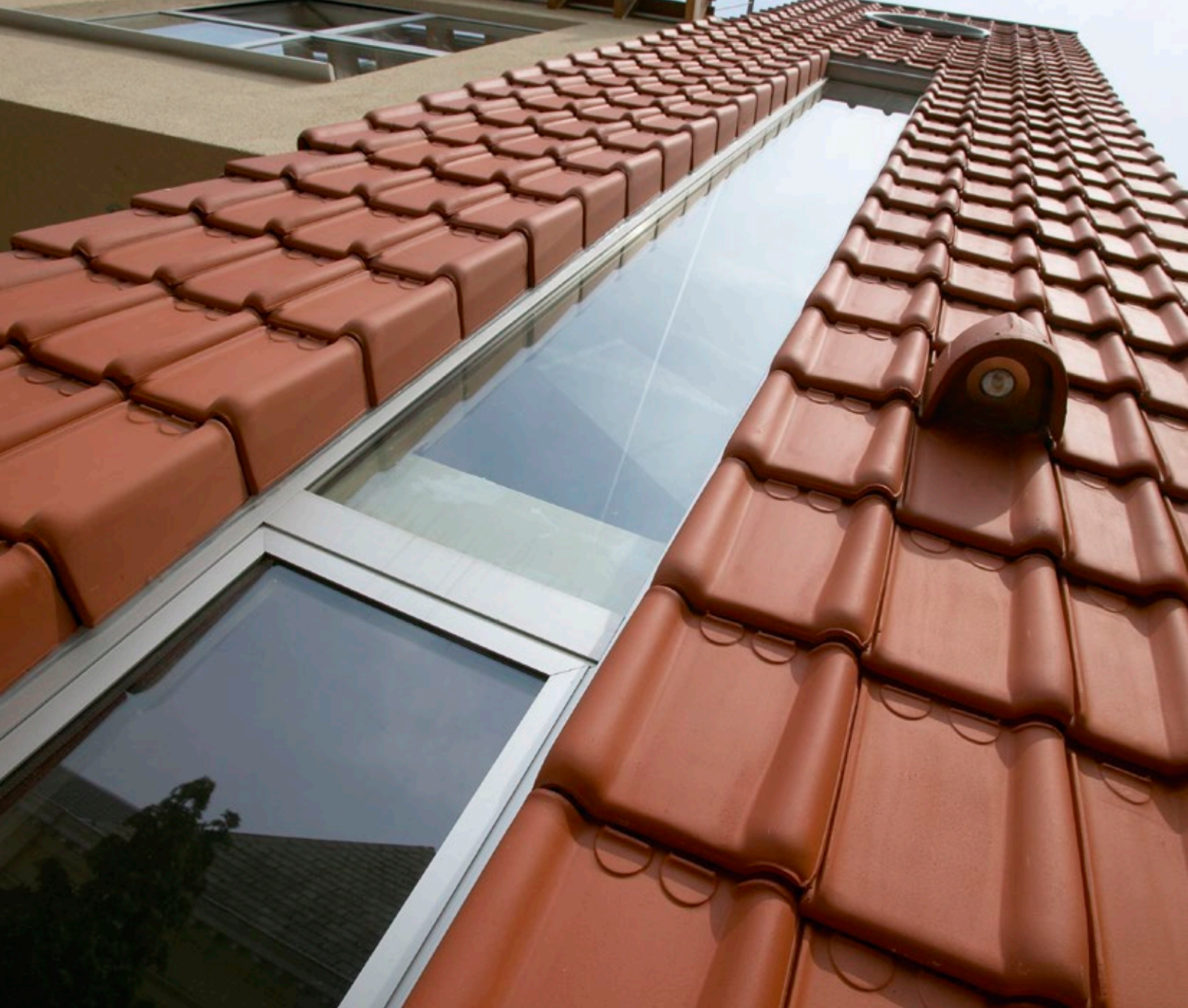
Na de renovatie
