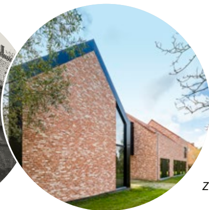
Na de renovatie
