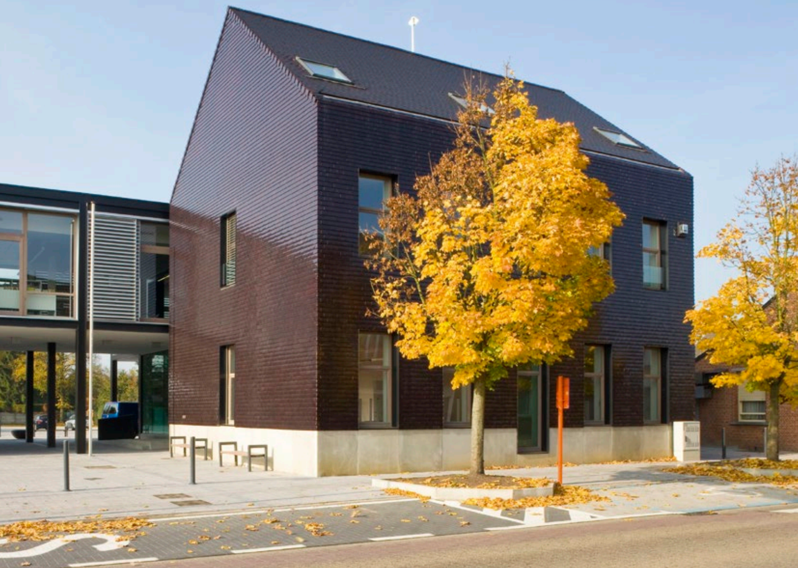
Na de renovatie
