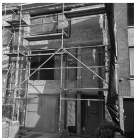
Voor de renovatie
