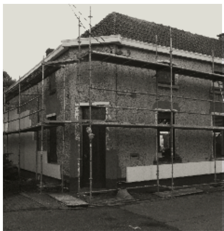
Voor de renovatie
