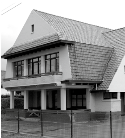
Voor de renovatie
