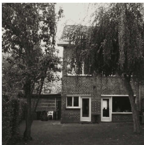
Voor de renovatie
