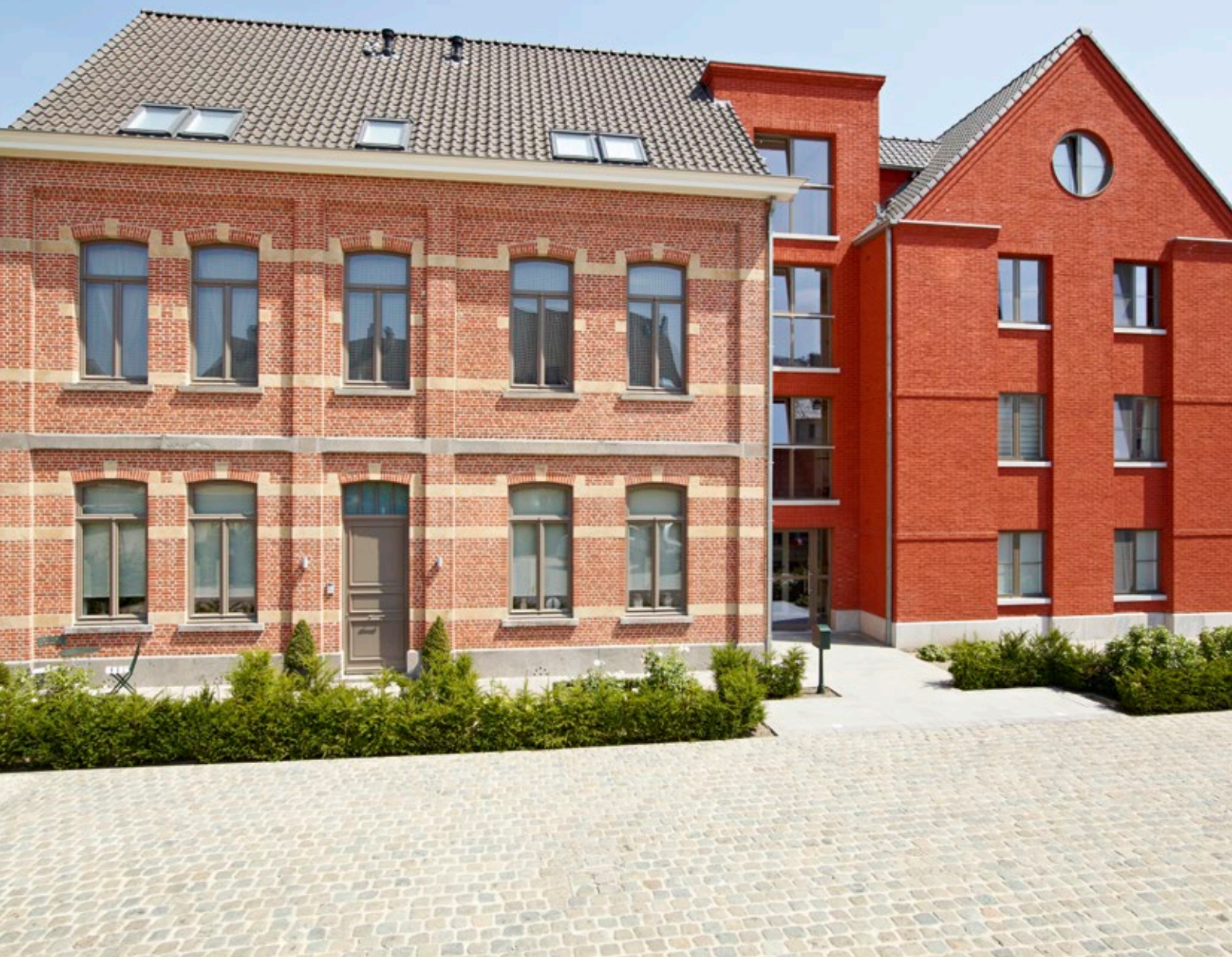
Na de renovatie
