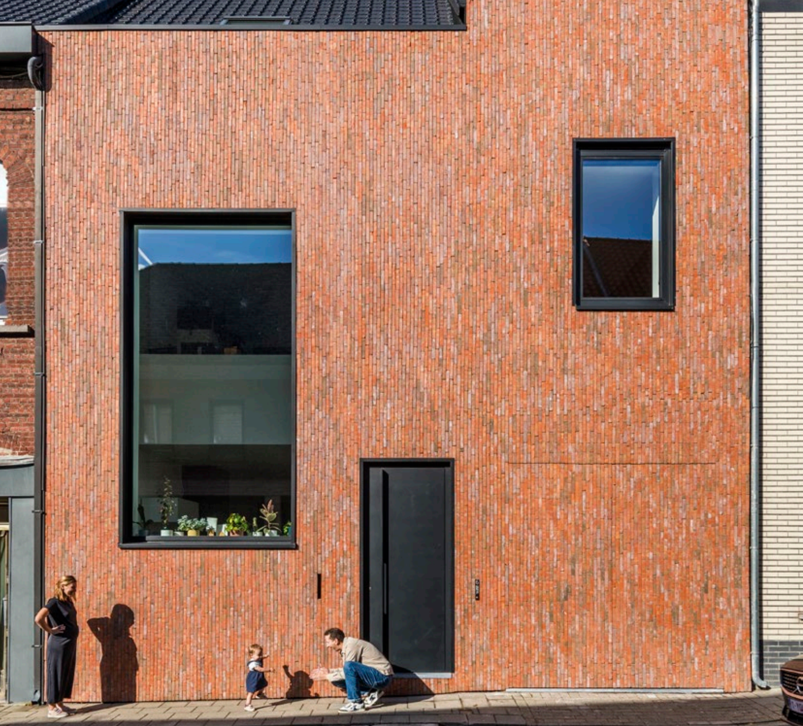
Na de renovatie
