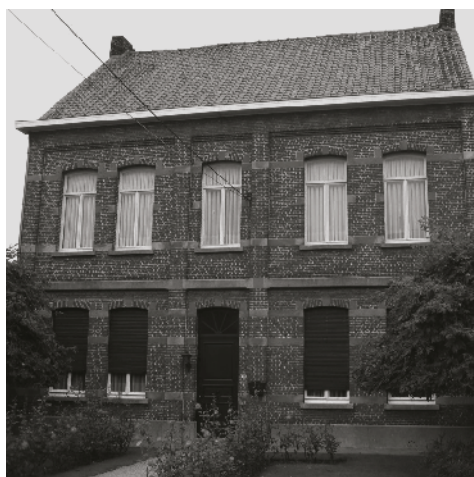
Voor de renovatie
