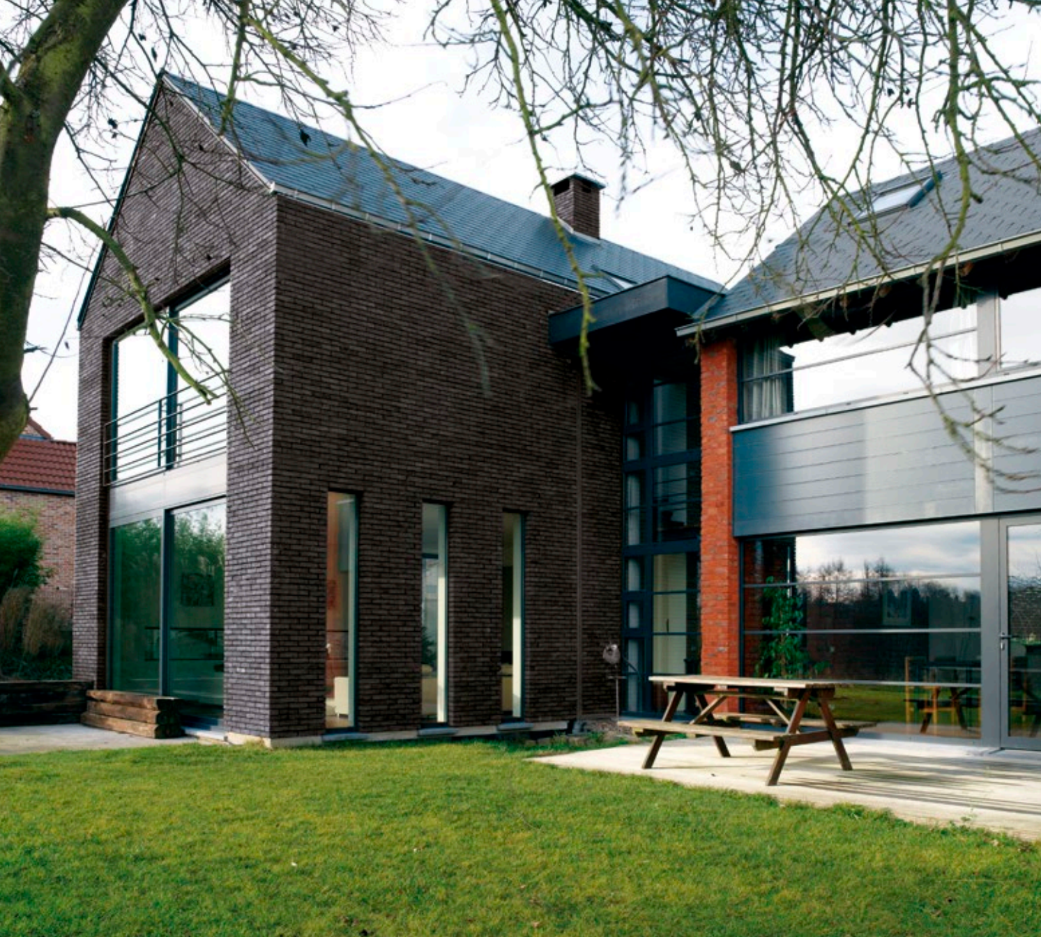
Na de renovatie
