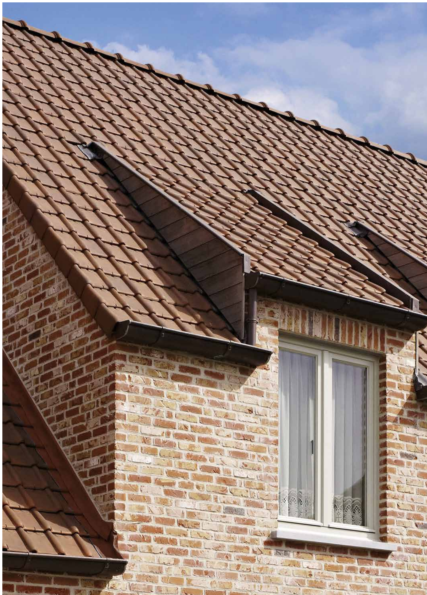
Tuile Tempête 44 Rustique: fixation des tuiles en utilisant des crochets de tuile visibles
