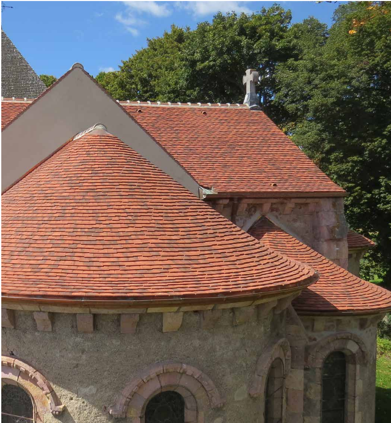
Tegelpan Pommard Bezand Bourgogne Renovatie
