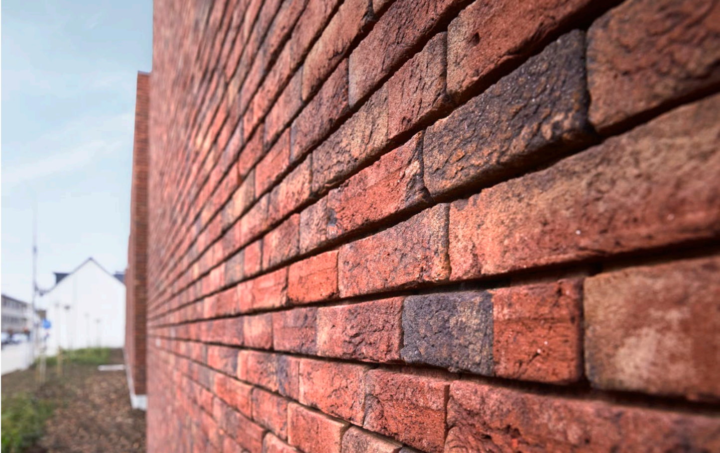
ClickBrick Pure Menton. Bouwheer en architect Colruyt Group, Halle
