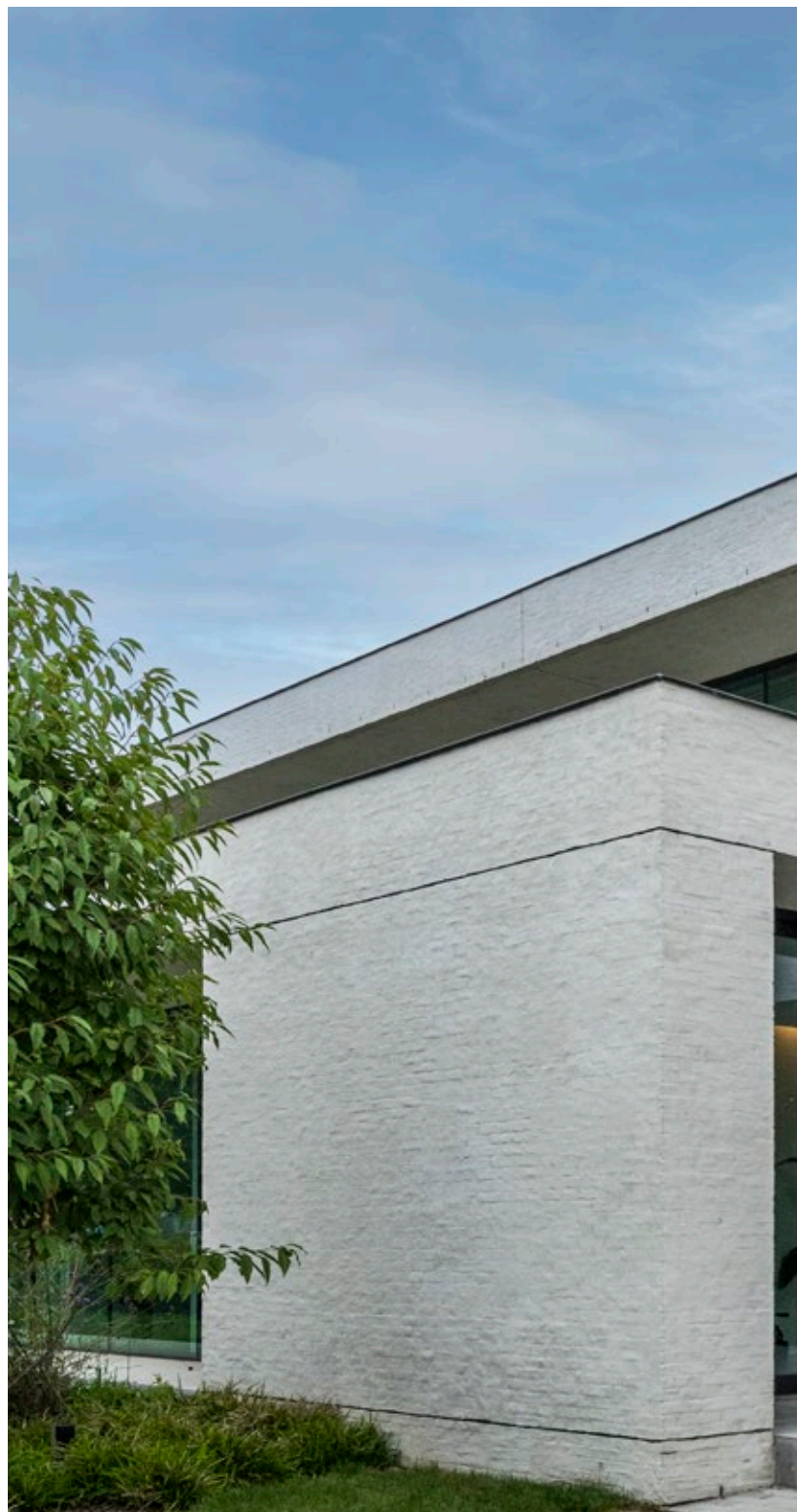
CG-architectes ont appliqué une finition au ciment sur les briques de parement Terca Amfora pour leur nouveau bâtiment de bureaux.
