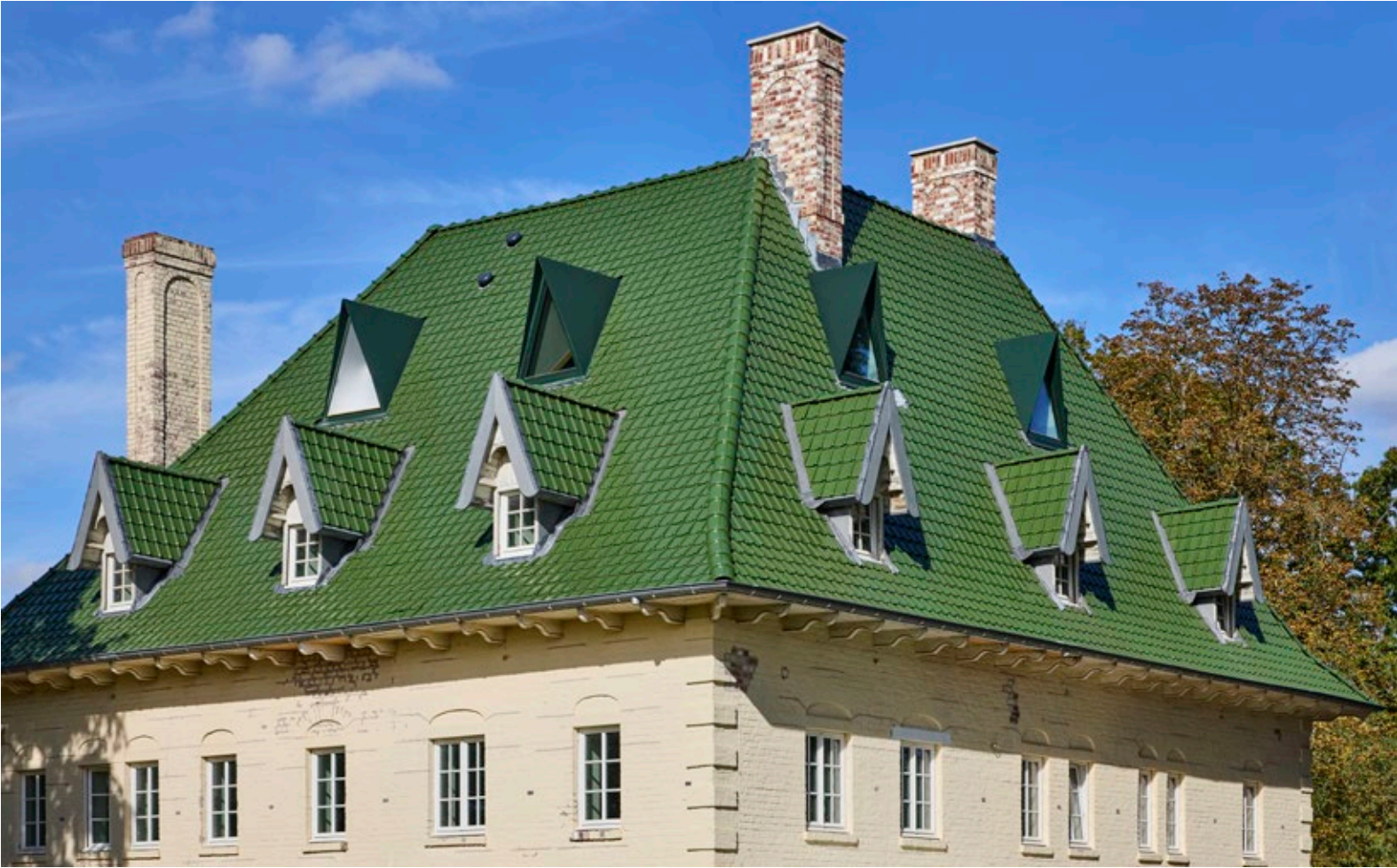
Renovatie van het landhuis Villa Zonnedaale op het kasteeldomein van Zonnebeke met de Koramic Stormpan 44 Donker grasgroen geglazuurd: een gedurfde keuze die erfgoed respecteert en tegelijk een frisse, eigentijdse uitstraling geeft aan het historische gebouw. STUDIOBONT architecten + Atelier Starzak Strebicki
