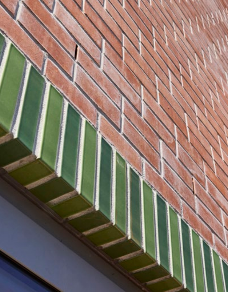
Renovatie Dorpshuis De Linde met Terca Glazuursteen Groen in 2 tinten: een eigentijdse interpretatie van AiT architecten van het traditionele metselwerk die duurzaamheid en esthetiek harmonieus verenigt.
