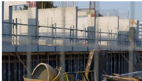
Wandliggers op betonnen vloerplaten of balken
