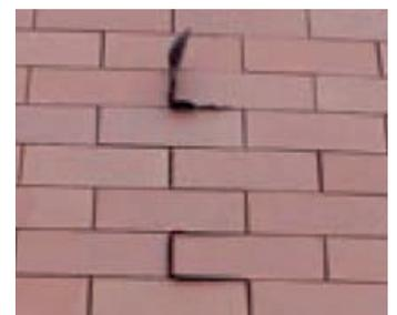
Membrane à hauteur du joint de dilatation lors de l'érection du parement
