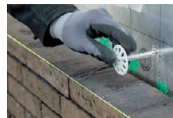
Installation des crochets d'ancrage lors de l'érection du parement
