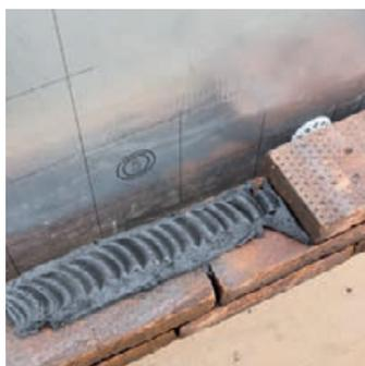
Photo 2: méthode de maçonnerie à joints minces en cas de brique non-perforée
