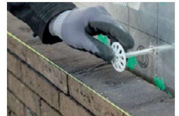
Installation des crochets d'ancrage lors de l'érection du parement
