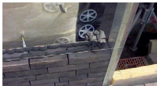
Photo 2: fixation mécanique de la membrane
