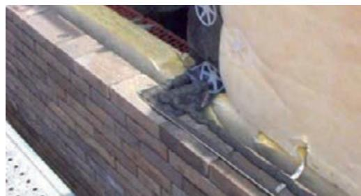
Photo 1: pose correcte de la membrane sous le seuil
