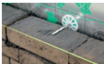
Correct inbedden van het spouwanker
