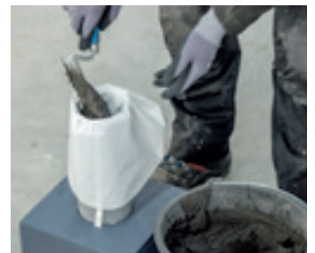
Foto 4: vullen van de spuitzak
