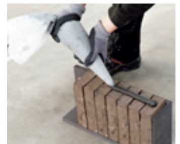
Gebruik van een mal voor het aanbrengen van mortel op de koppen
