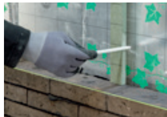
Plaatsing spouwankers bij het optrekken van de gevel
