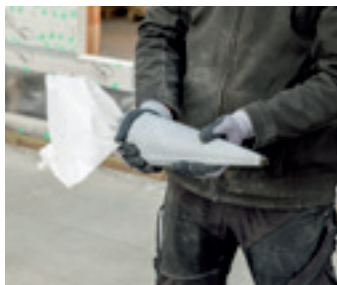
Foto 1: correct gebruik spuitzak
