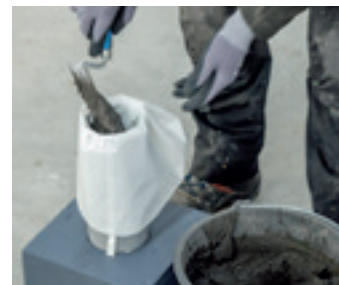
Foto 4: vullen van de spuitzak
