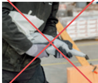
Foto 2: foutief gebruik spuitzak
