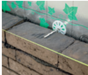
Correct inbedden van het spouwanker
