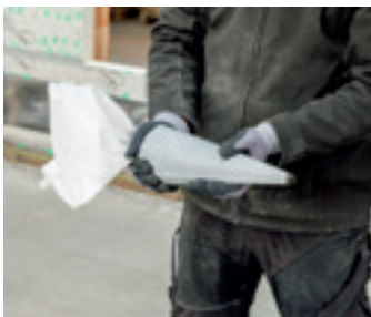
Foto 1: correct gebruik spuitzak
