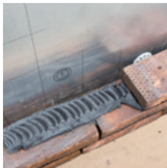
Foto 2: dunbedmortelmethode bij niet geperforeerde steen
