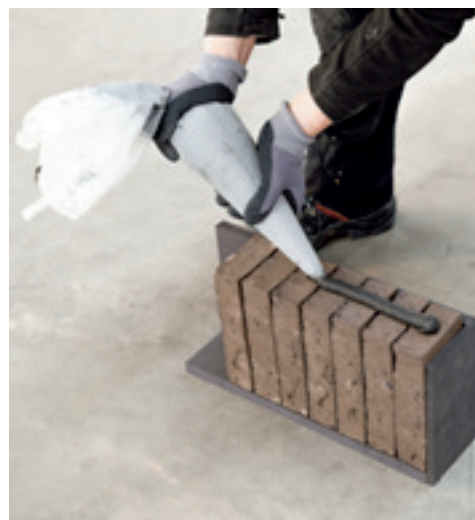
Gebruik van een mal voor het aanbrengen van lijm op de koppen
