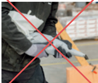
Foto 2: foutief gebruik spuitzak
