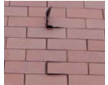
Folie ter hoogte van de dilatatievoeg bij het optrekken van de gevel
