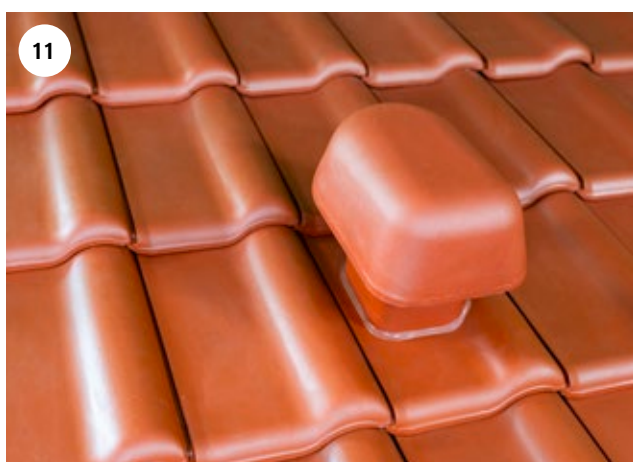
Posez les tuiles environnantes et complétez la couverture
