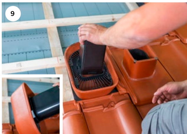
De aansluitingsbuis en de keramische kap worden met elkaar verbonden door middel van een kliksysteem.
