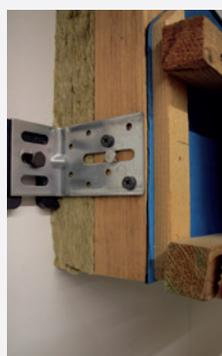
En utilisant des étriers développés spécifiquement à cet effet en acier galvanisé, en aluminium ou en inox pour fixer la structure portante verticale en bois, l'isolation pourra être appliquée en une seule et même couche continue.
