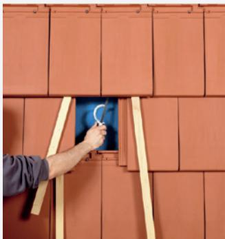
4. Eliminez les fixations (par ex. au moyen d'une scie à métaux).
