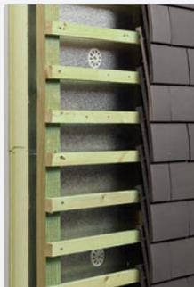
Il existe sur le marché des systèmes permettant d'appliquer des panneaux isolants rigides en formant une seule et même couche continue. A l'aide de vis réglables spéciales, il sera possible d'appliquer une structure en bois autoportante une fois le bouclier isolant totalement installé.
