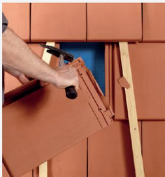
5. Supprimez si besoin quelques reliefs pour une 'repose' plus aisée, sans détruire complètement les emboîtements d'étanchéité..
