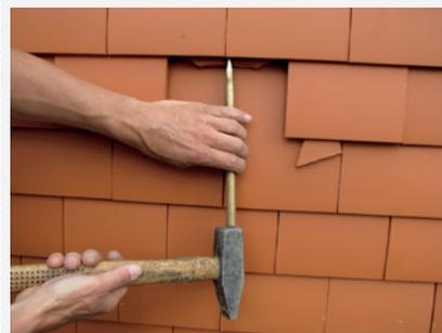
3a. Eliminez les éléments céramiques restants au marteau et au burin. Seules les fixations métalliques doivent encore être présentes.
