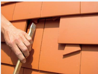
3b. Éliminez les éléments céramiques restants au marteau et au burin. Seules les fixations métalliques doivent encore être présentes.
