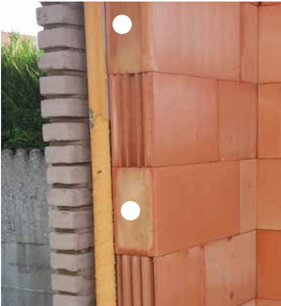
○ Plaatsen waar er ankers kunnen bevestigd worden
