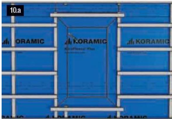
Afin de ne pas nuire à l'étanchéité au vent de la sous-toiture nous conseillons fortement de placer une bande supplémentaire de sous-toiture au-dessus de la fenêtre de toit, celle-ci démarrante au niveau du premier recouvrement de 2 laies de sous-toiture au-dessus de la fenêtre de toit.
