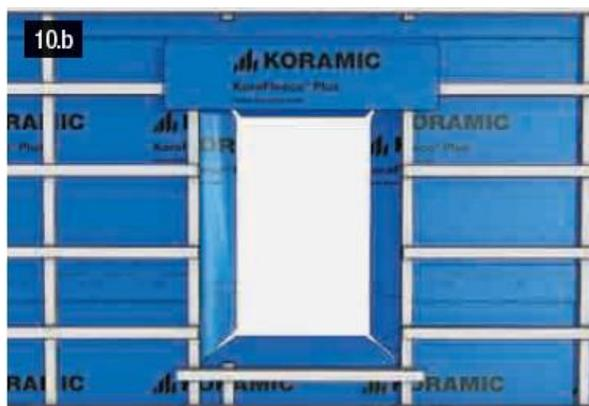
Remontez la membrane et fermez dans les angles avec le Koramic Multi-Tape. Posez la fenêtre de toit et le cadre isolant du kit énergie BDx selon les instructions de VELUX.
