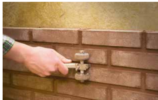
Doorstrijken met voegroller (bron: Weber)
