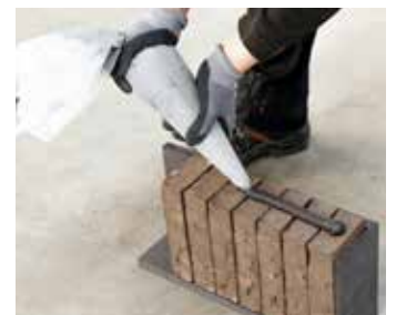
Gebruik van een mal voor het aanbrengen van mortel op de koppen
