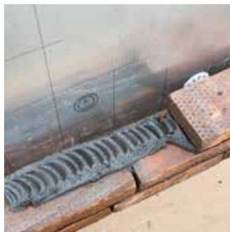
Foto 2: dunbedmortelmethode bij niet geperforeerde steen
