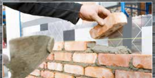
TRADITIONEEL METSELWERK ACHTERAF OPGEVOEGD
