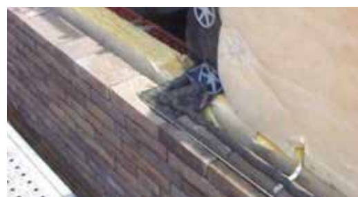
Foto 1: correcte plaatsing folie onder de dorpel
