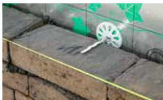
Correct inbedden van het spouwanker
