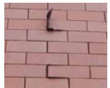
Folie ter hoogte van de dilatatievoeg bij het optrekken van de gevel
