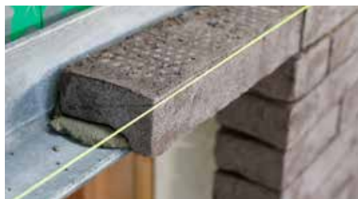
Plaatsing L-profiel
