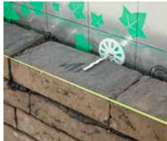
Correct inbedden van het spouwanker
