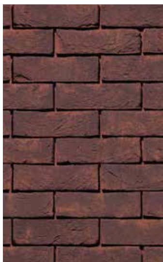
Gelijmde stenen
