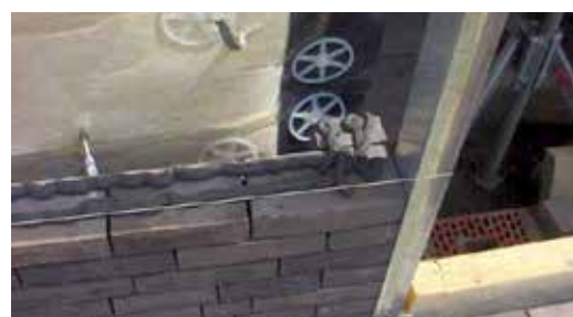
Foto 2: mechanische bevestiging van de folie
