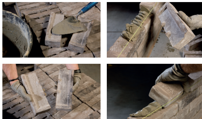
Photo 3: pose de briques Iluzo
