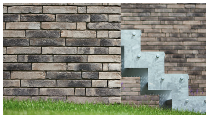
Foto 2: gevel afgewerkt met Iluzo
