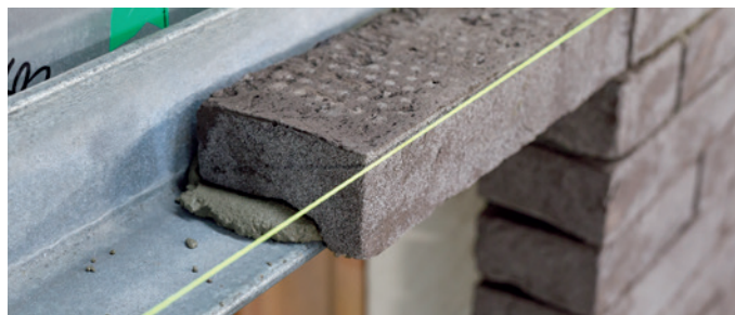
Foto 6: plaatsing L-profiel
