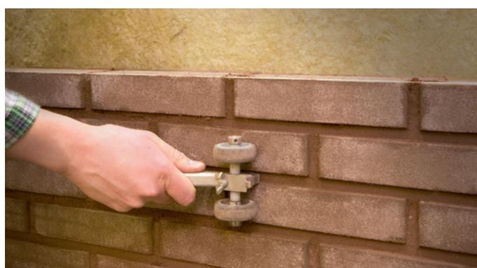
Photo 4: jointoiment à plein-bain au rouleau à jointoyer (source: Weber)
