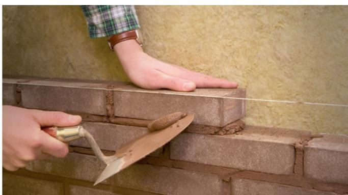
Photo 2: application pleine et saturée du mortier (source: Weber)
