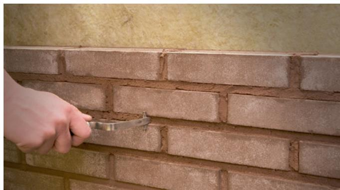
Photo 3: jointoiment à plein-bain au fer à joints (source: Weber)
