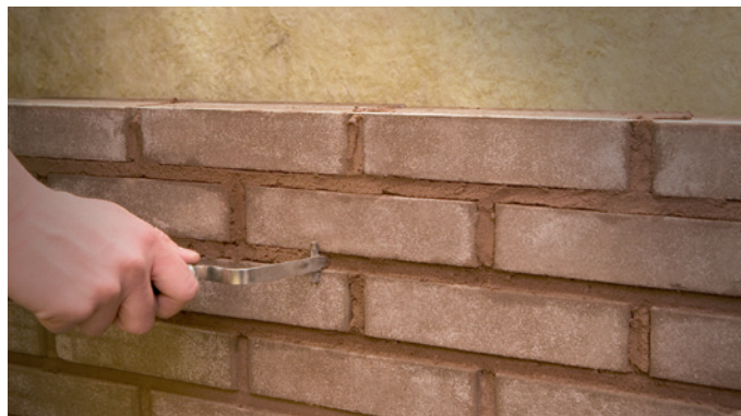
Foto 3: doorstrijken met voegijzer (bron: Weber)
