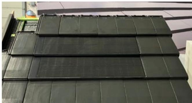
2. Les dimensions de la tuile Actua 10 sont 303 x 472 mm<sup>2</sup>. Cela exige un lattage de 360 à 380 mm et une inclinaison minimale de 24° au niveau de la toiture pour intégrer les modules X-Tile.
