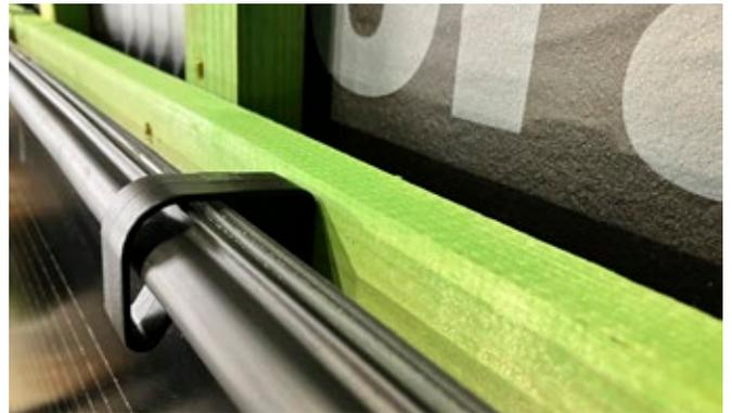
11. Chaque panneau Wevolt X-Tile doit en outre être fixé sur le côté gauche de la gouttière à l'aide d'un crochet pour panneau avec la vis correspondante ou d'une vis pour tuile de 4,5 x 60 mm.
