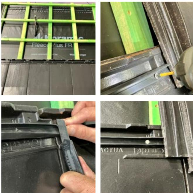
7. Utilisez les étriers de fixation fournis pour fixer les modules sur les liteaux en plaçant les étriers dans les trous pré-fraisés supérieurs à gauche et à droite.
