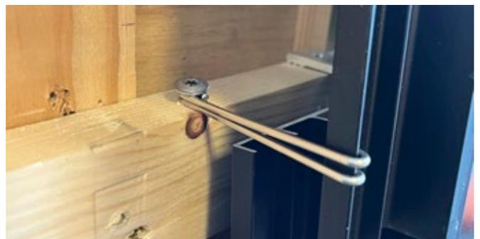
12. Fixez toutes les tuiles en contact avec les modules Wevolt X-Tile BIPV à l'aide du crochet de tempête pour tuiles Actua fourni par Wienerberger. C'est une étape importante pour garantir une bonne étanchéité et une bonne résistance au soulèvement par le vent. Procédez comme suit :
