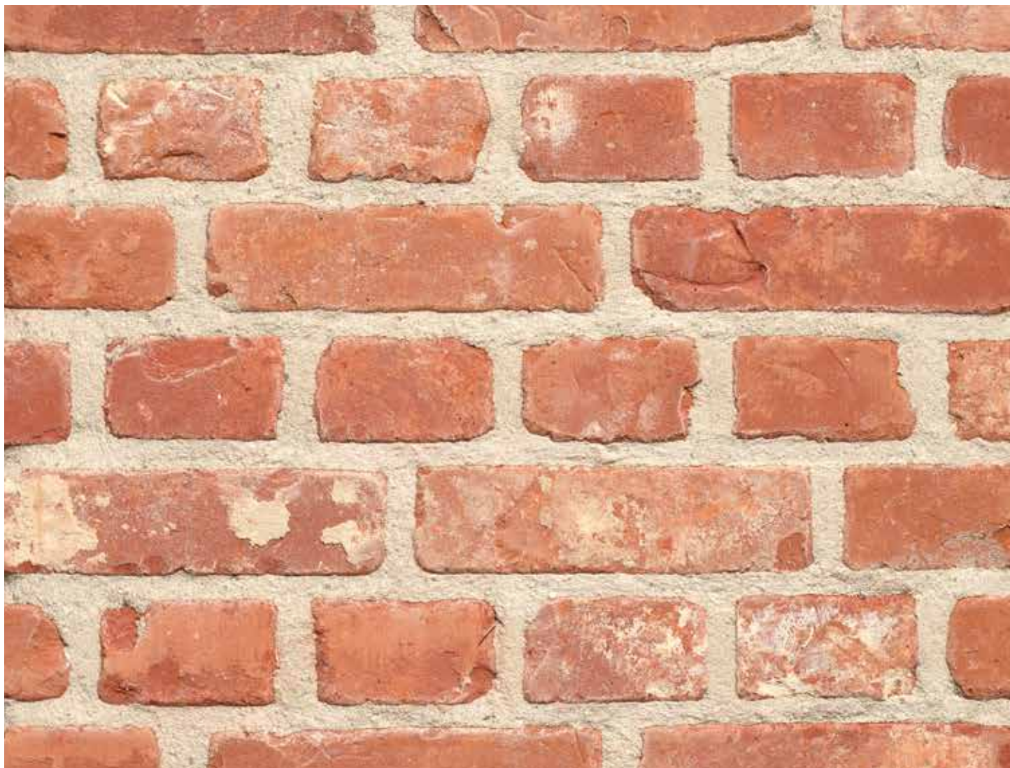
Schijnvoeg / Faux joint
